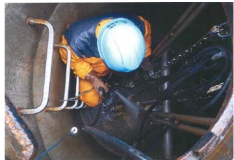
写真 2-1 マンホールポンプ洗浄工の作業状況例
