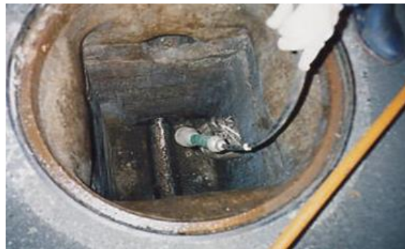
図 5-9 取付け管テレビカメラ調査工の作業模式図
