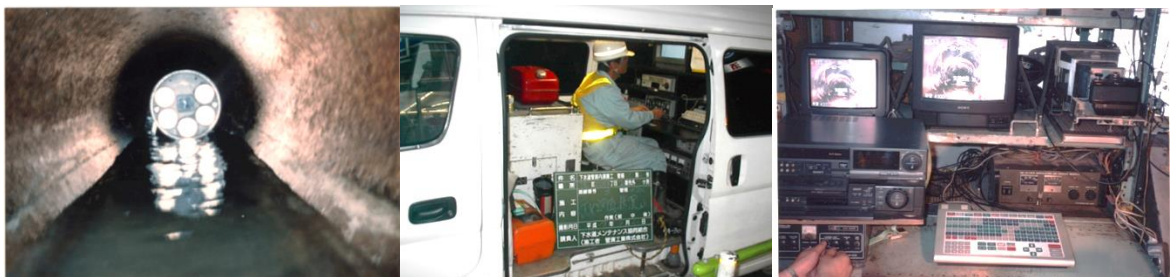
写真 5-1 カメラヘッド（管径 200～800mm 未満に対応）
