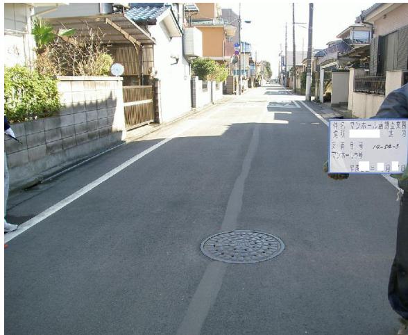
写真 3-2 巡視の全景写真
