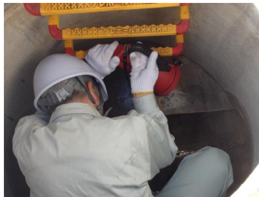
写真 4-2 マンホール内目視による点検（小口径）
