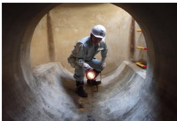
写真 4-1 マンホール内目視による点検（大口径）
