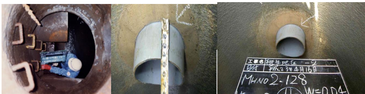
写真 5-6 マンホール目視調査の例
