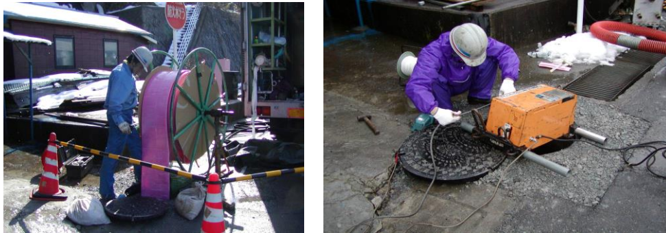
写真 1-2 形成工法（更生工法）の一般的な施工状況（事故とは無関係）
