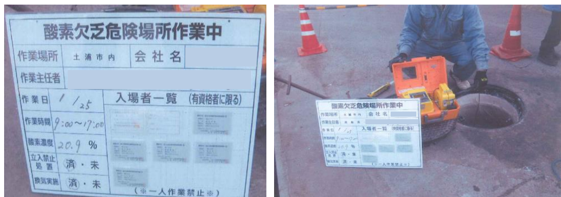
写真 2-1 作業主任者の掲示板
