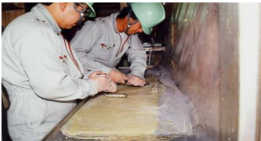
写真 8-3 更生材料（硬化性樹脂）の含浸
