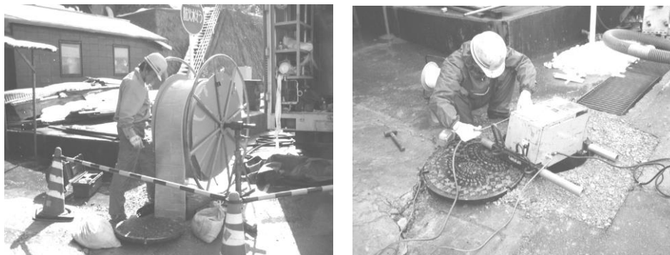
写真 4-2 形成工法（更生工法）の施工状況
