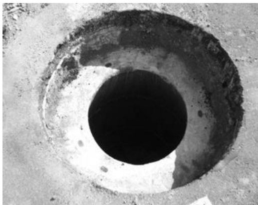
写真 7-1 マンホール蓋取替工法の施工例（左：円形、右：矩形）
