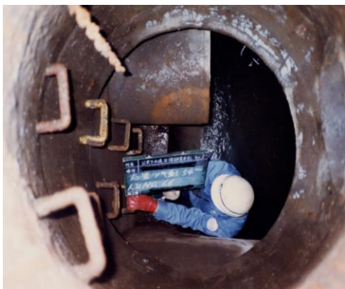
写真 8-5 マンホールの調査
