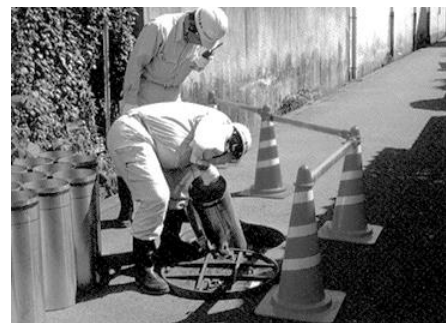
写真 4-4 さや管工法の施工状況 →
