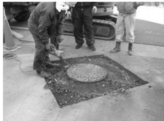
写真 7-1 マンホール蓋取替工法の施工例（左：円形、右：矩形）
