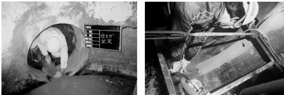
写真 8-1 Vカット工法の施工状況
