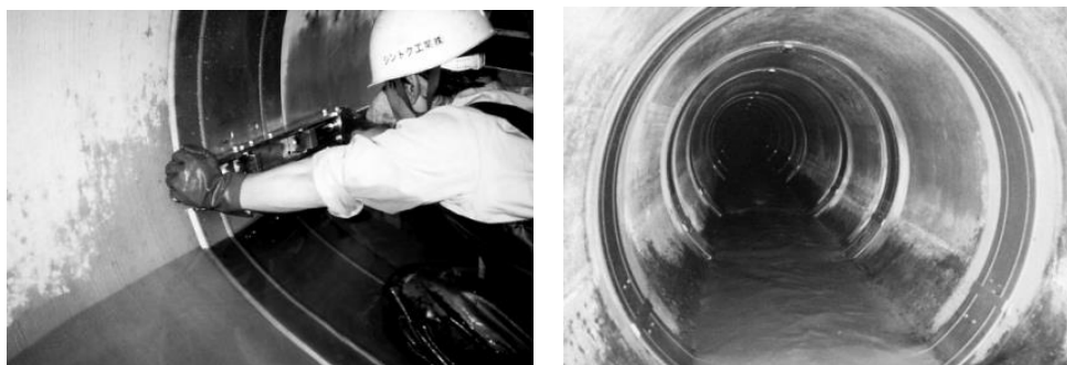
写真 8-2 リング工法の施工状況
