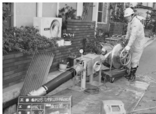
写真 7-2 反転工法(取付け管更生工法)の施工状況
