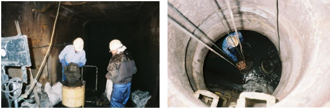
写真 3-10 人力清掃の作業状況
