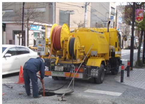
写真 3-1 高圧洗浄車清掃状況
