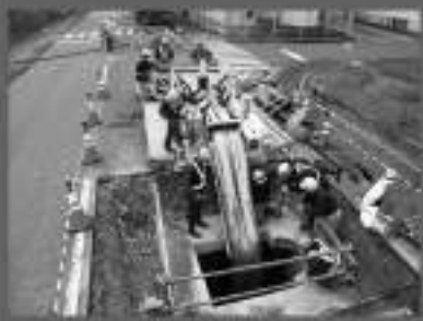
材料引込設置状況
