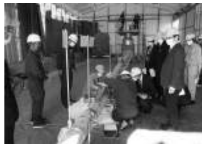
審査証明委員会による現場立会試験の様子
