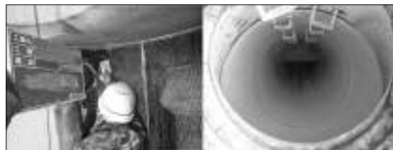
マンホール耐震補強ライニング
