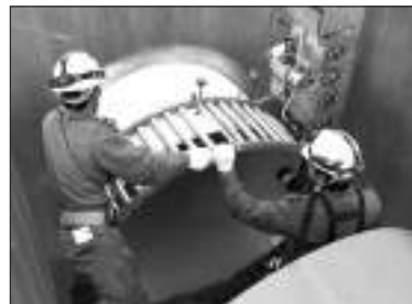
製管作業（元押し方式）
