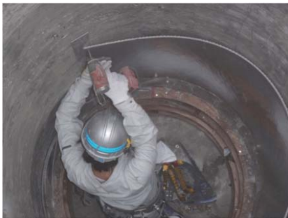
シート設置状況 (例)
