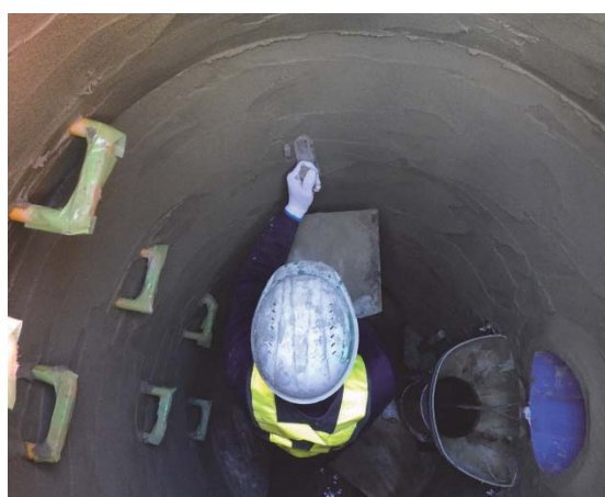
モルタルライニングの施工状況（例）
