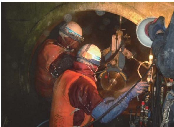
誘導目地切削状況（例）
