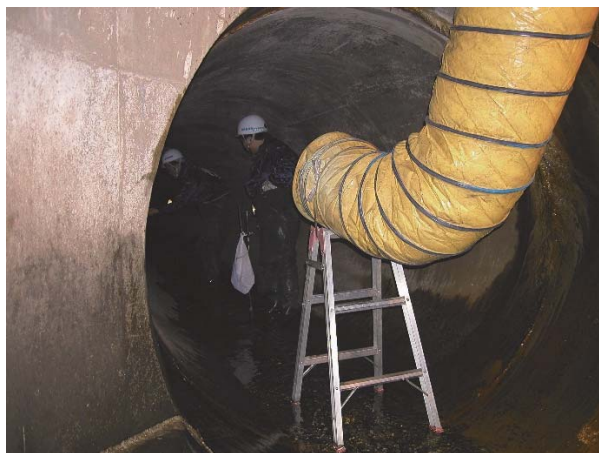
風管の設置状況（例）
