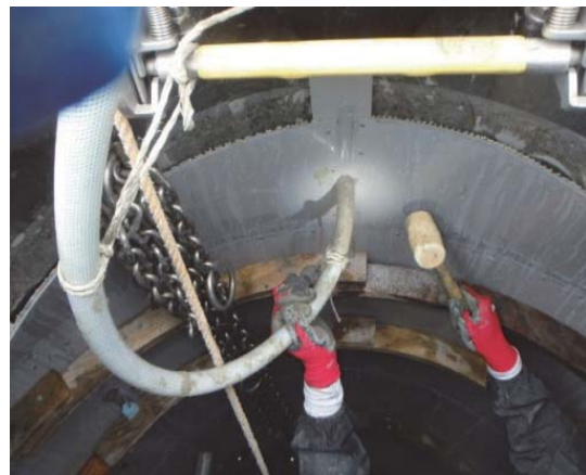
充填材注入状況 (例)
