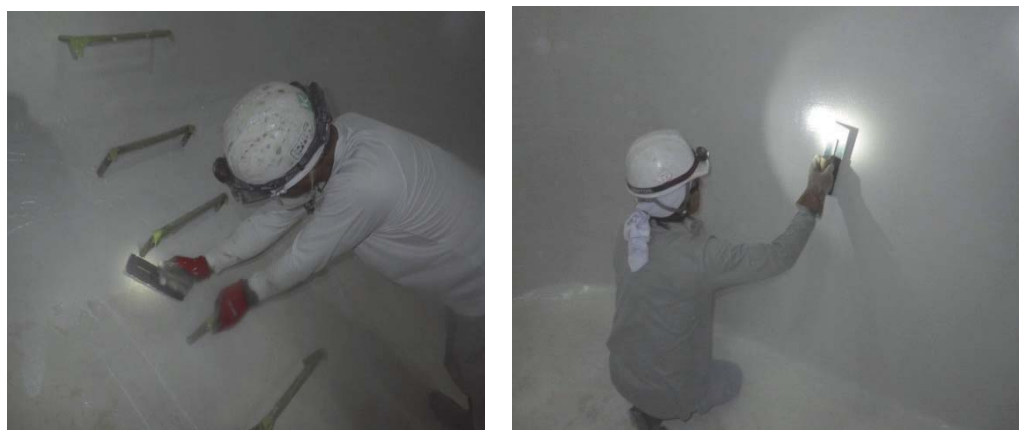
塗布型ライニング工法の施工状況（例）
