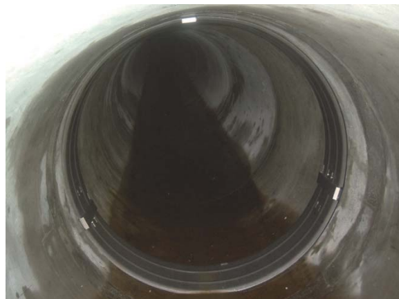
リング設置状況（例）
