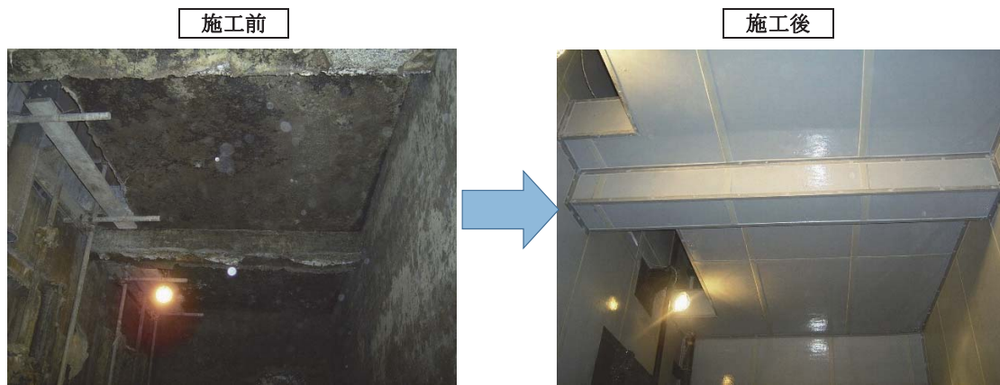
シートライニング工法のく(矩)形構造施工例 (例)
