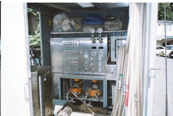
止水コントロールパネル・ポンプ
