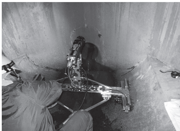
写真6 テレビカメラ人孔内組立状況
