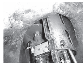
①既設管の切削除去
