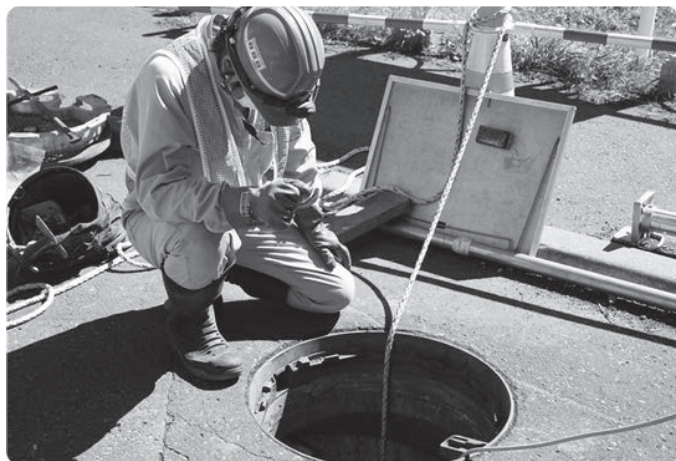
写真－1 下水道管路の点検作業状況
