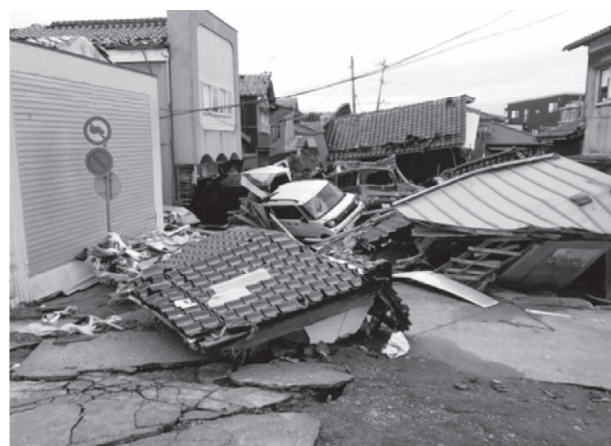
写真―2 家屋の倒壊
