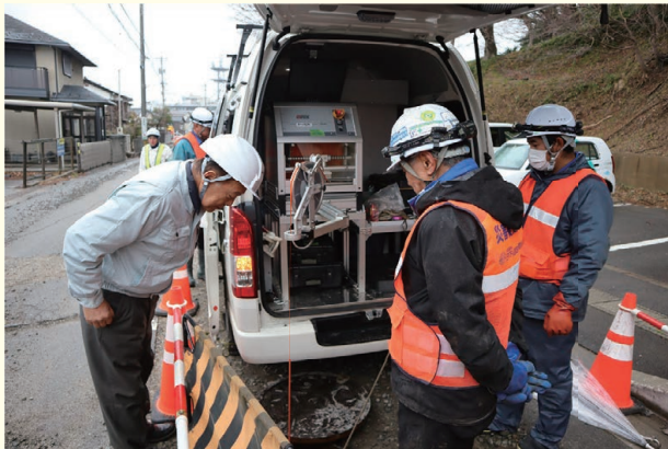
テレビカメラによる二次調査の現場を視察
