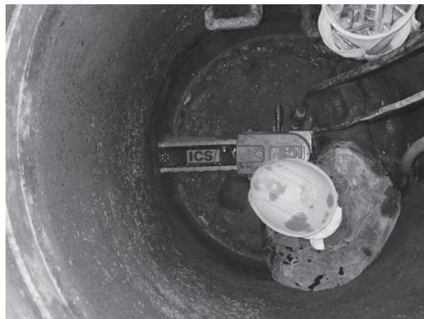
チェーンソー式切削機械での切削作業
