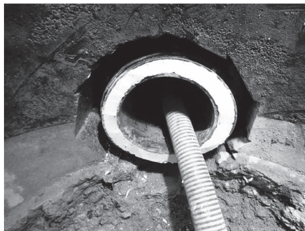
耐震継手TTJ設置完了
