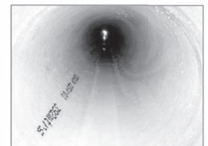
④管更生工事
