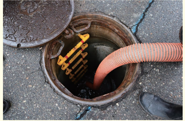
滞留した汚水を吸引し輸送
