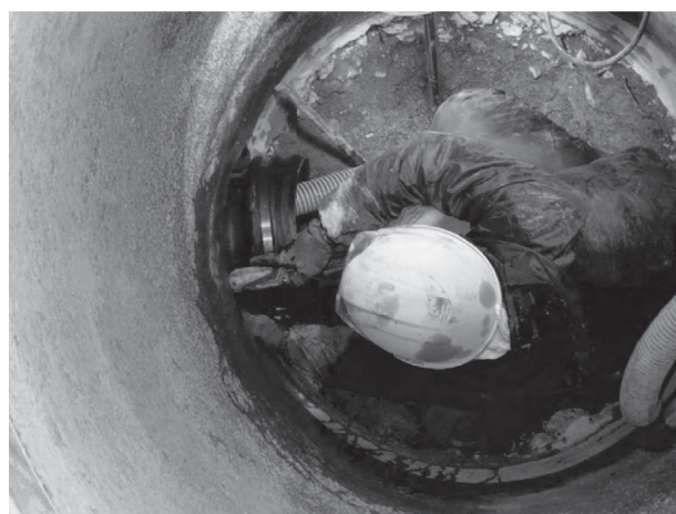
耐震継手TTJ取付状況
