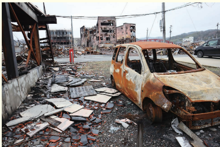
火災の被害を受けた輪島朝市通り周辺
