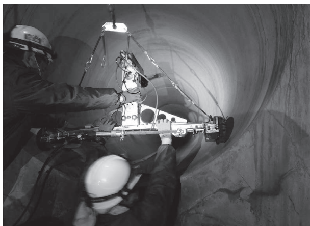
写真7 テレビカメラ上流管口セット状況
