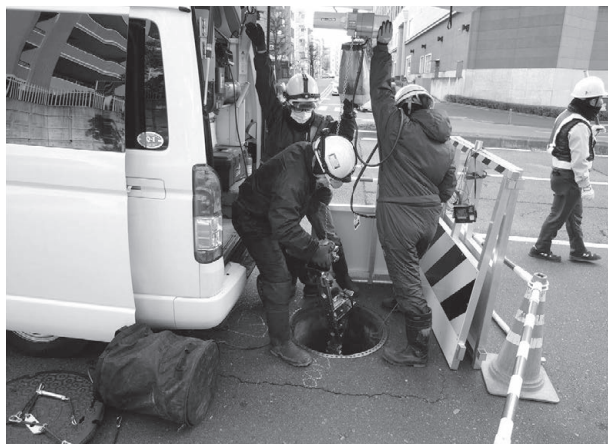
写真5 テレビカメラ人孔内投入状況
