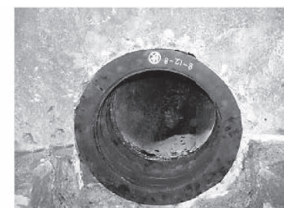
②耐震ゴムリングの設置
