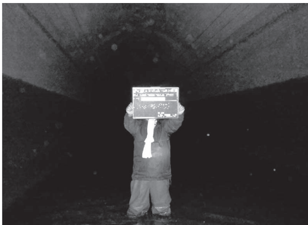
写真2 雨水貯留管の調査状況
