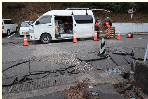
テレビカメラによる二次調査の現場
