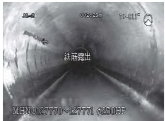
写真1 腐食して鉄筋が露出した下水道管
