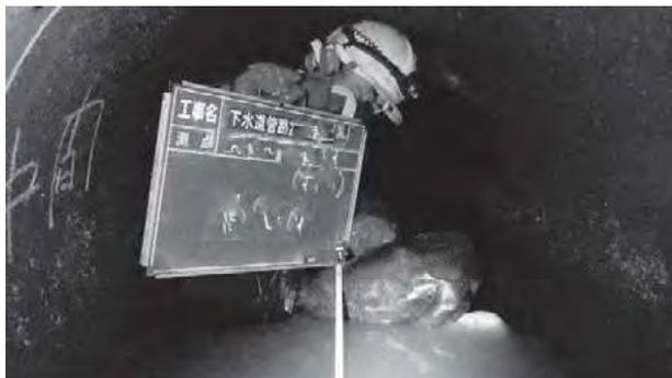
図1 口径800mmの管内潜行目視調査の作業状況
