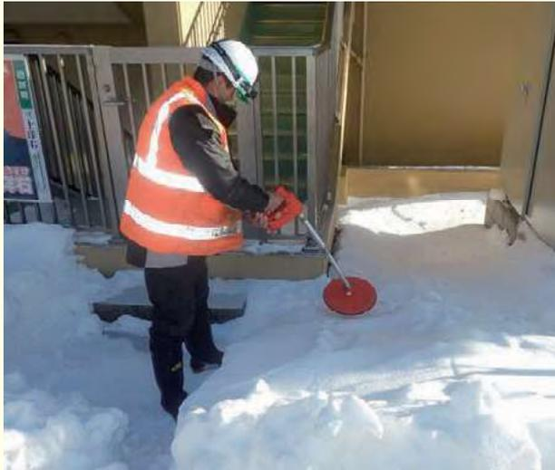
雪で覆われているとマンホールを探すのも困難、金属探知機でマンホールを探知して発見する
