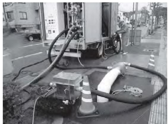
写真2 更生工法施工状況
