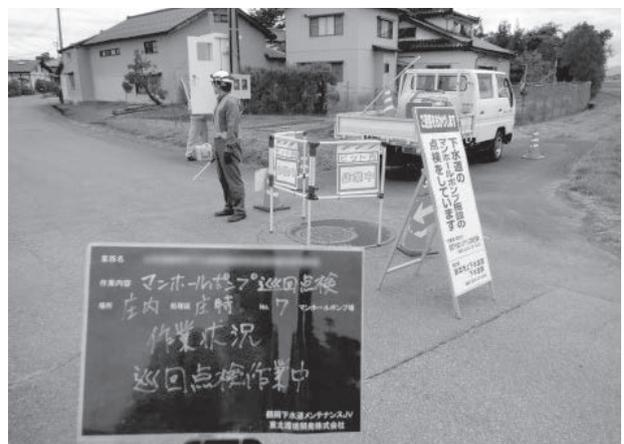
写真2 マンホールポンプ巡回点検作業状況
