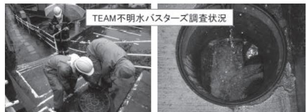
図6 TEAM 不明水バスターズによる調査状況と雨天時浸入水の流入状況
