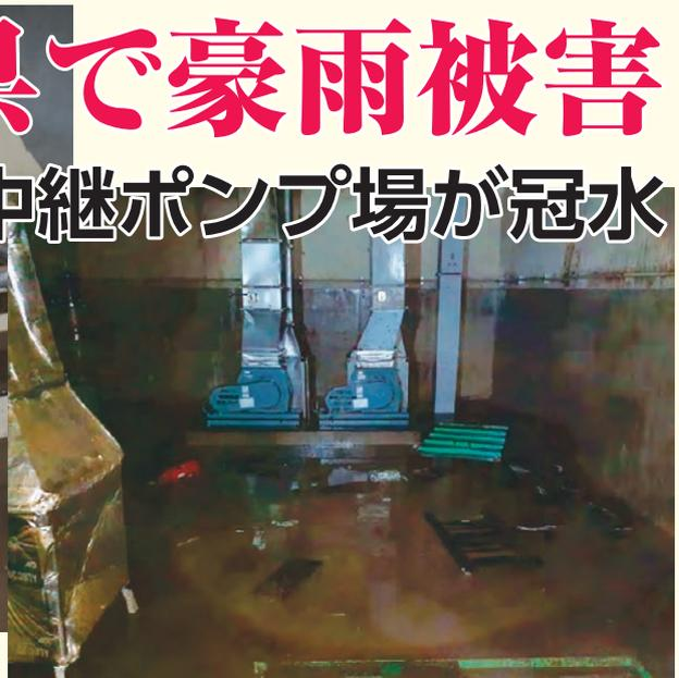
同ポンプ場地下1階換気ファン室浸水状況
