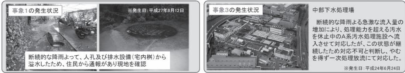
図5 雨天時浸入水に起因する各事象の発生状況
