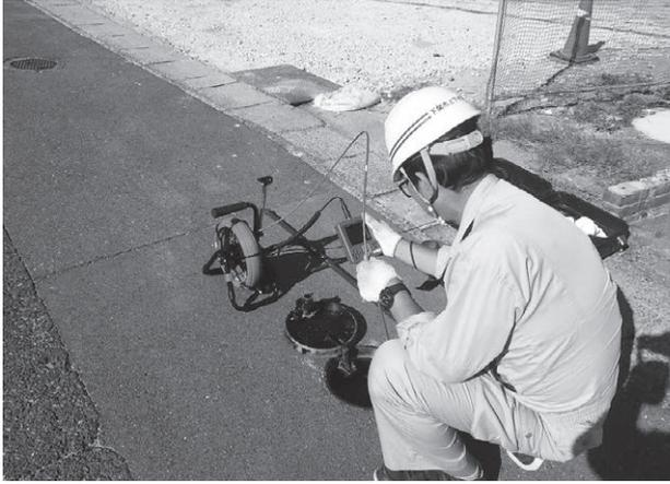
写真6 管内検査カメラによる点検状況
