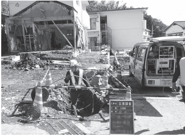
写真11 取付管TVカメラ調査状況
