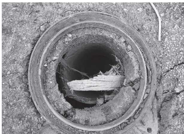
写真7 被害（ずれ）
