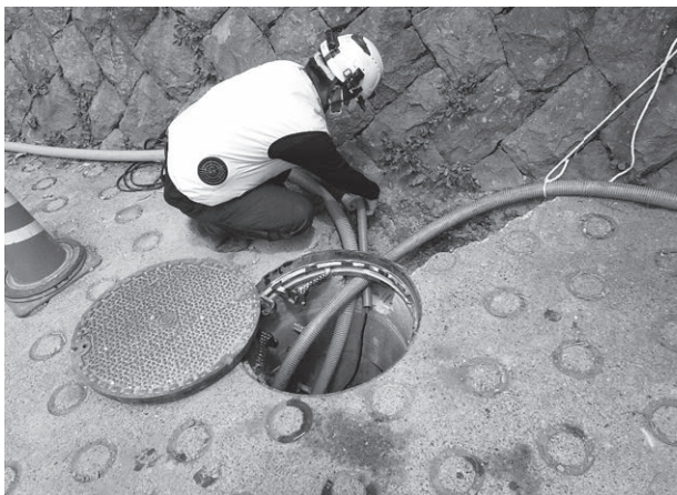
写真13 排水ホース設置状況
