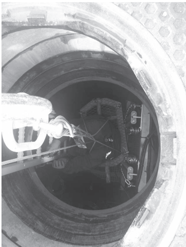
吊り足場作業場を設置
