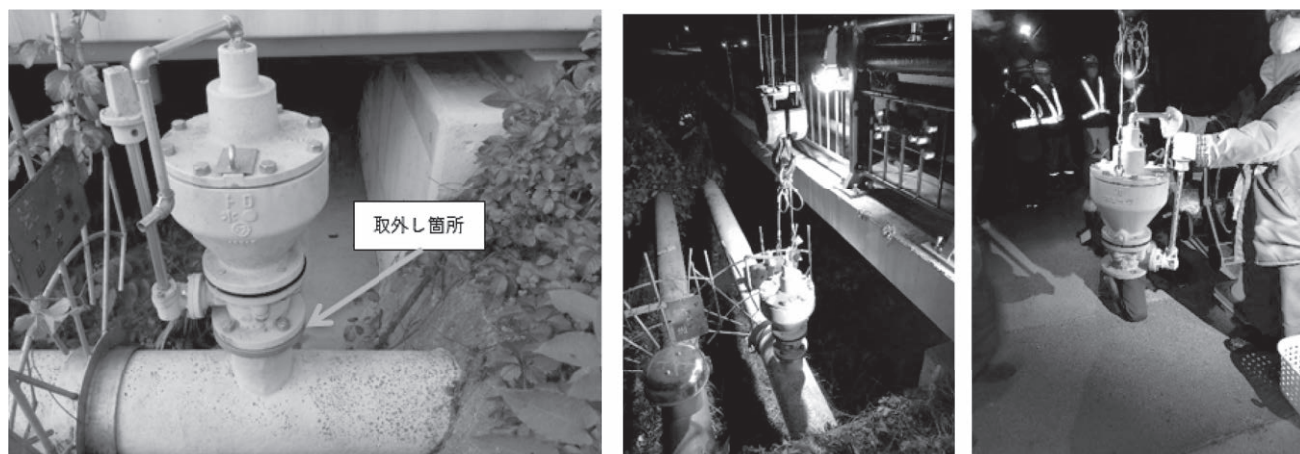
写真2 空気弁撤去の状況
