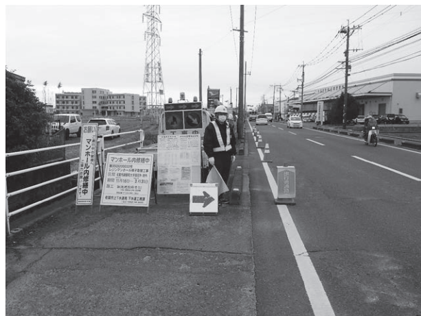
工事看板の設置とガードマンを配置
