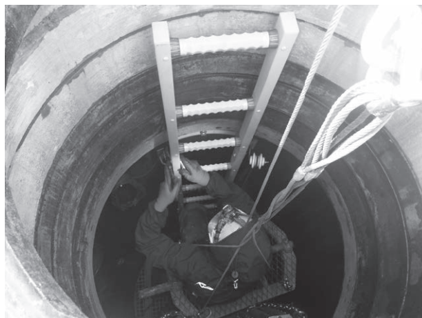
新梯子の取り付け作業
