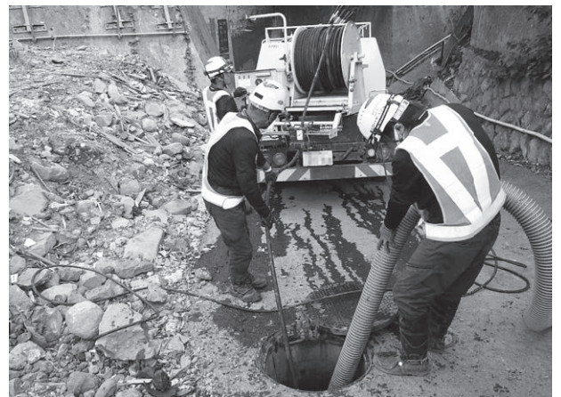
写真4 東海道新幹線高架手前での吸引作業
