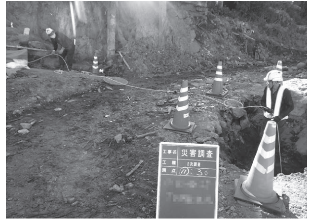
写真12 TVカメラ調査状況
