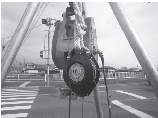
電動ホイストの設置状況
