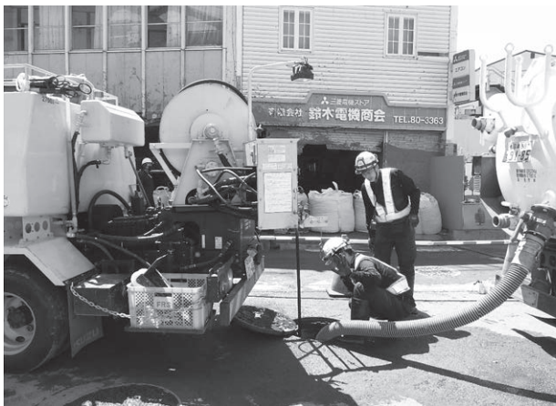
写真3 通行止めとなった国道135号線での作業
