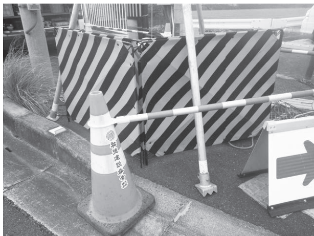
工事箇所を防護柵で覆う
