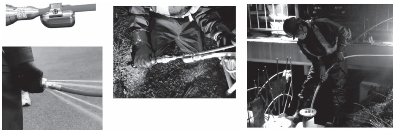
写真6 アジリオスのケーブルに洗浄ノズルを装着
