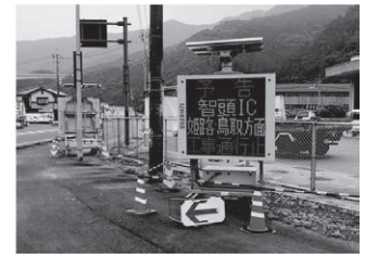
工事通行止めの事前予告
