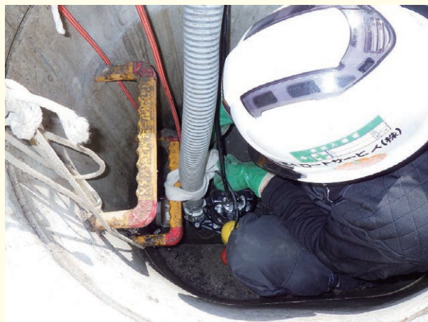
仮設ポンプを設置
