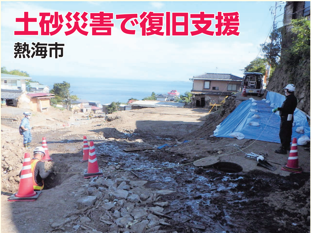
アスファルトやマンホール蓋が土石流で削り取られた中で2次調査を実施
