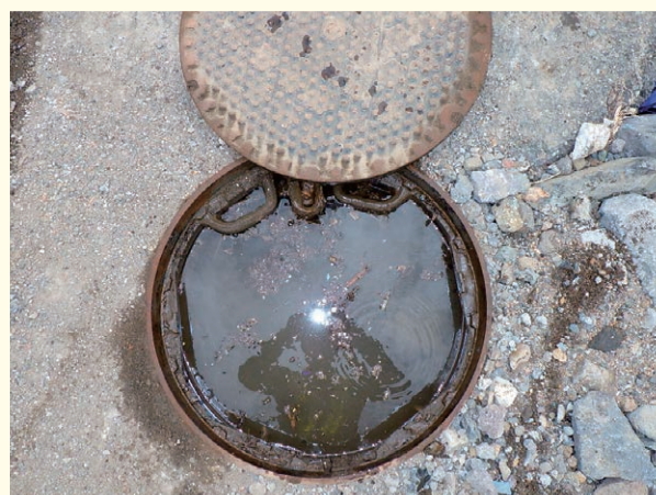
マンホール内に滞水した汚水
