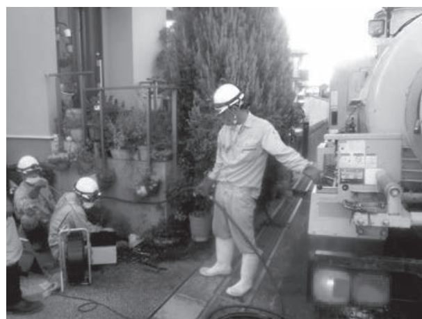
写真2 取付管内に侵入した木根の根切り除去の状況
