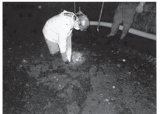
写真5 雨水貯留管施工中
