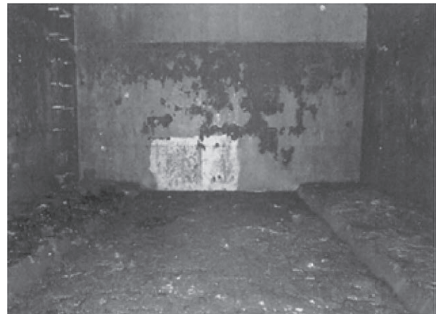
写真4 雨水貯留管施工前
