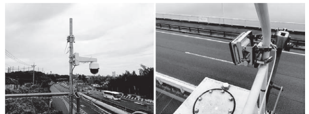
Webカメラやセンサーによる遠隔監視
