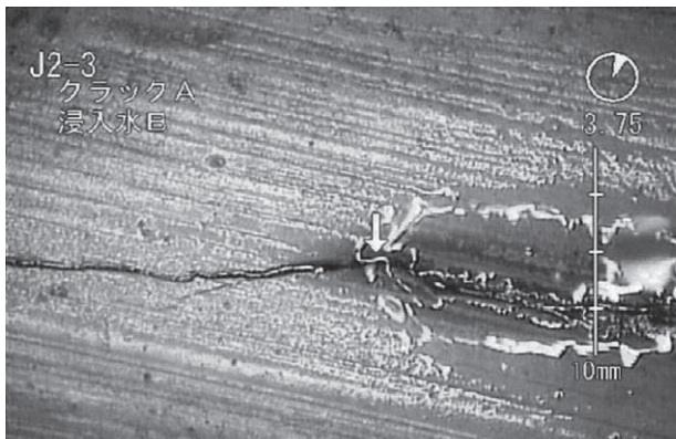
写真3 下水道管の被害状況（クラック）
