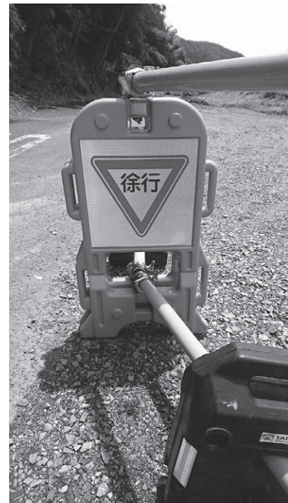
KYサインバリケードの設置状況（上下）
