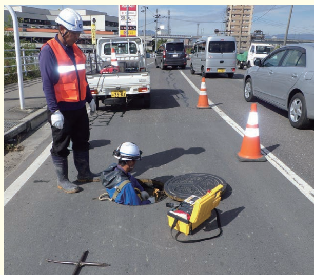
堆砂量調査状況（郡山市）
