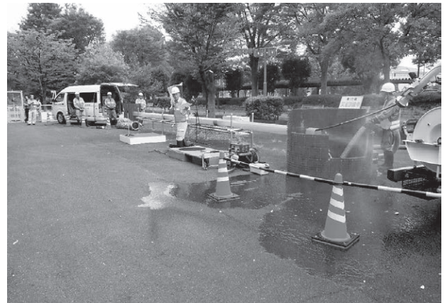
管内の洗浄訓練
