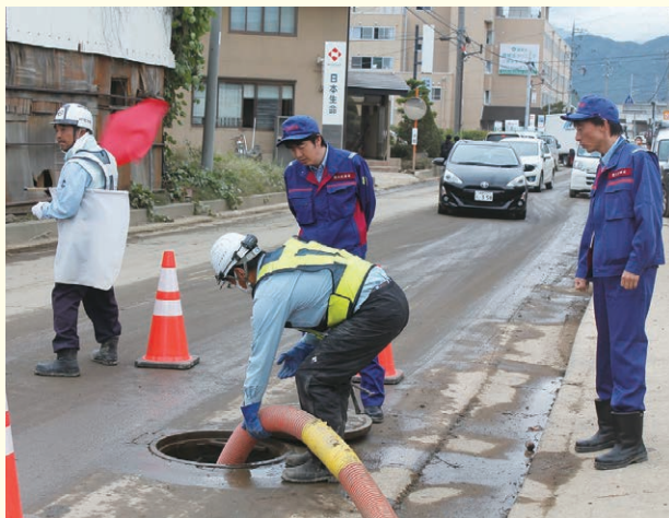
長野市内の復旧支援の状況視察（国土交通省下水道部下水道企画課の本田康秀下水道事業調整官（右）、同課中西啓輔国際展開推進係長（中央奥））
