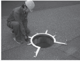
枠を取り付ける
