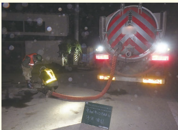
管内滞留汚水の吸引作業（長野県）
