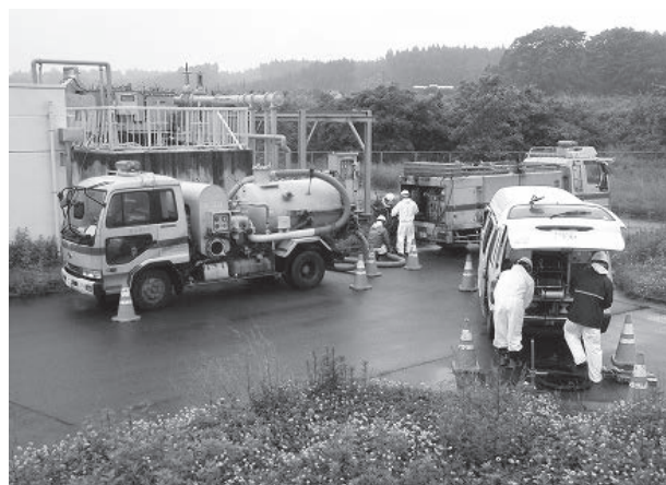
作業状況①
