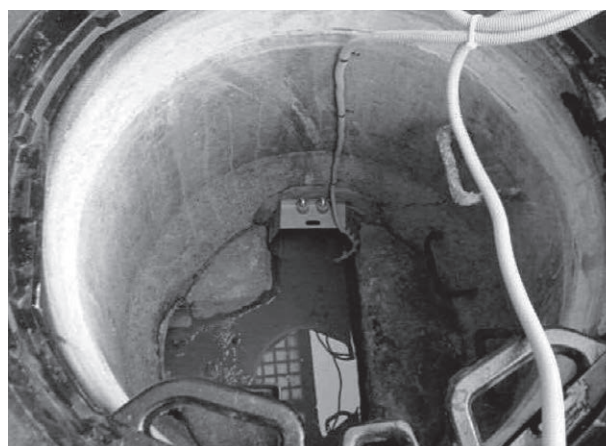
写真4 水位センサ設置事例2
