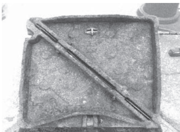
写真2 マンホール蓋の老朽化状況
