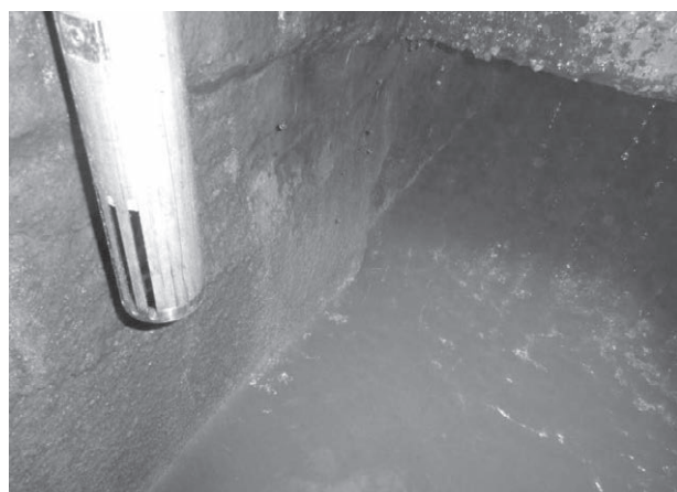
写真3 水位センサ設置事例1
