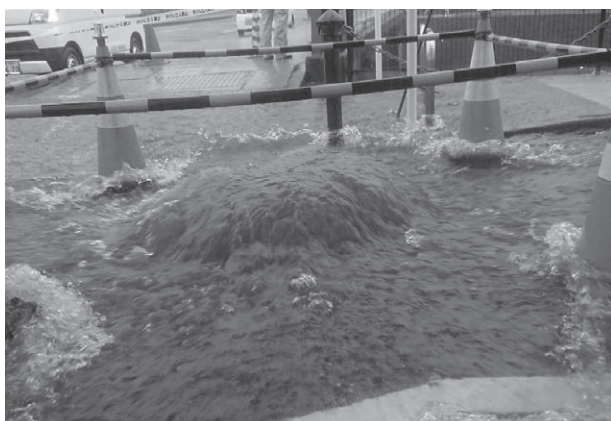
写真3 汚水噴出時の状況
