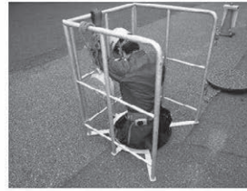
安全帯を付けて 設置時間 約10秒
