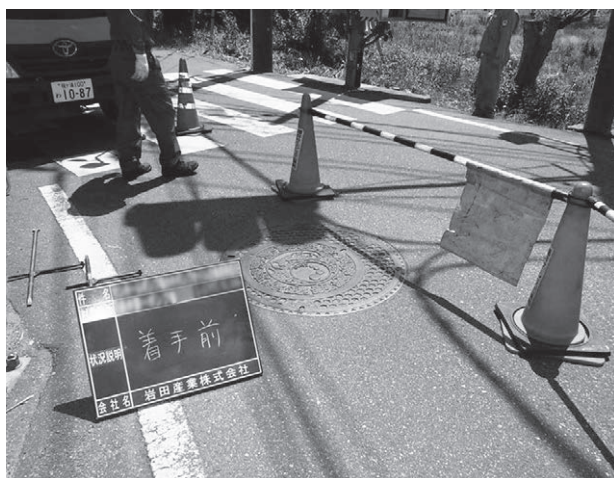
マンホールポンプ点検時の様子①。 写真からわかるように工事範囲が非常に狭い。
