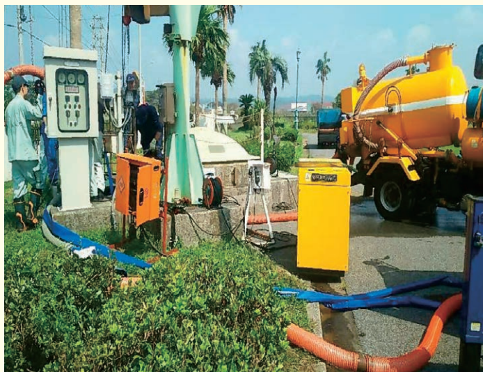
吸引用設備据え付け状況（館山市）
