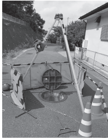
レスキューシステム設置の様子
