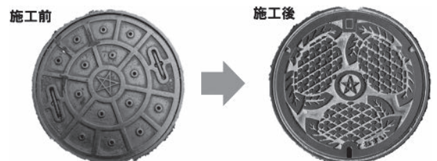
穴あきマンホール鉄蓋から密閉性の高いマンホール鉄蓋への取替
