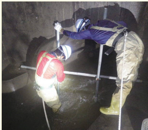
堆砂量調査状況（郡山市）
