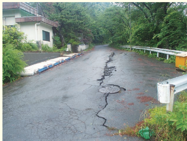
温海地区の被災状況（鶴岡市）
