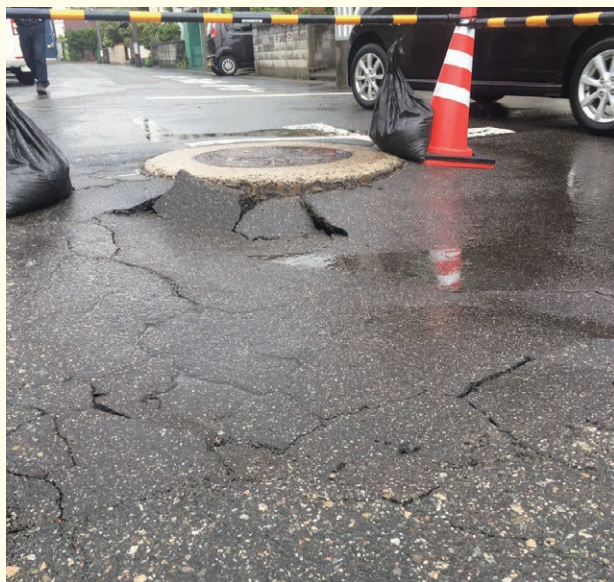
鶴岡地区の被災状況（鶴岡市）
