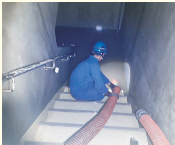
鳩山第2中継ポンプ場での汚水吸引作業（毛呂山・越生・鳩山公共下水道組合）
