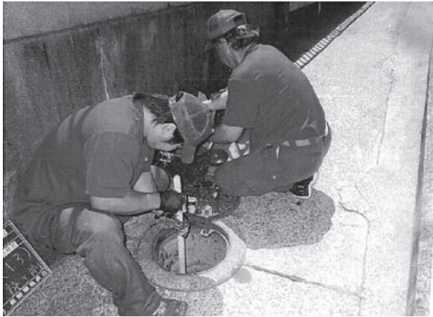
目地補修作業
