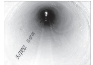
④管更生工事
