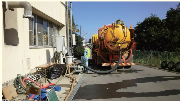
汚水をバキュームカーで移送（三郷町提供）
