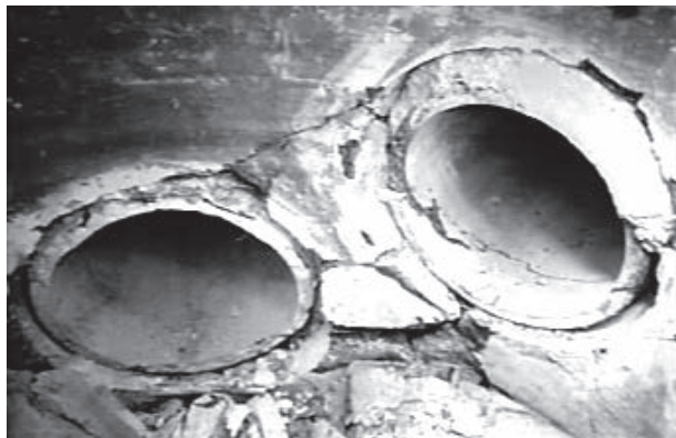
写真1 地震によるマンホールと管きよ接続部破損状況
