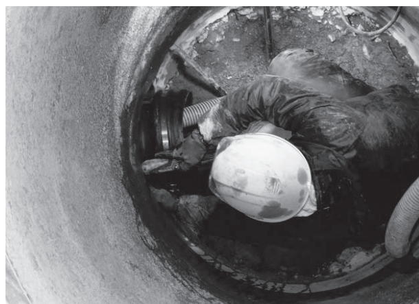
耐震継手TTJ取付状況
