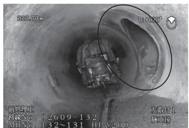
取付管突出し部除去前（左）、除去後（右）
