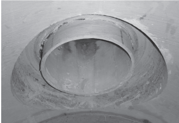
切削工完了（工法1）
