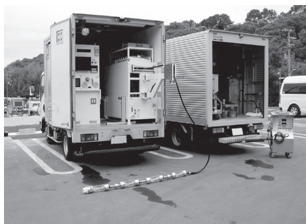
写真2 コンパクトな管更生工事用車両
