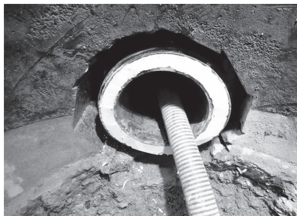
耐震継手TTJ設置完了
