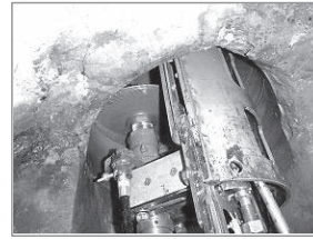
①既設管の切削除去
