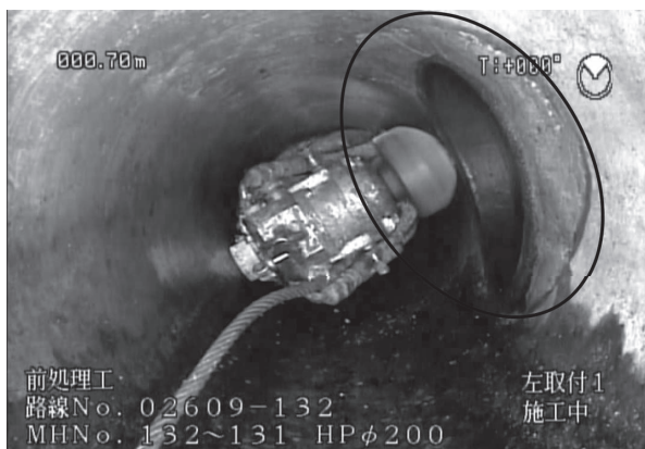
取付管突出し部除去前（左）、除去後（右）
