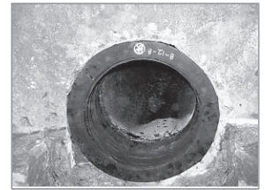
②耐震ゴムリングの設置
