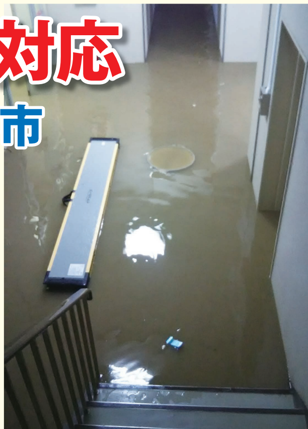
ポンプ場に汚水が流入（三郷町提供）
