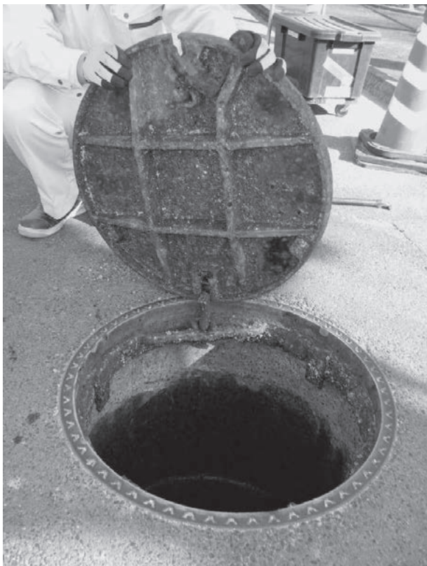
老朽化した鉄蓋の様子
