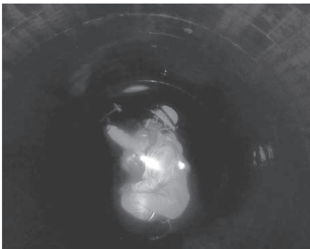
管更生施工の様子②
