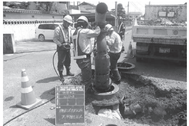
特殊ポンプ設置状況
