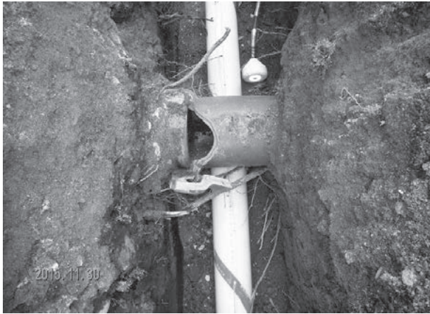
取付陶管破損状況
