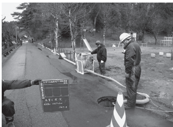
水替え工の様子（φ400mm, L=69m）
