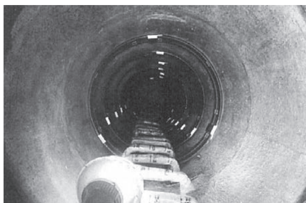
既設マンホールの継手部耐震化施工例
