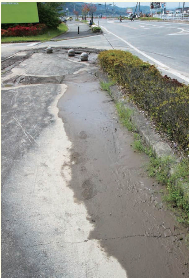
液状化とみられる現象も確認（熊本県益城町）
