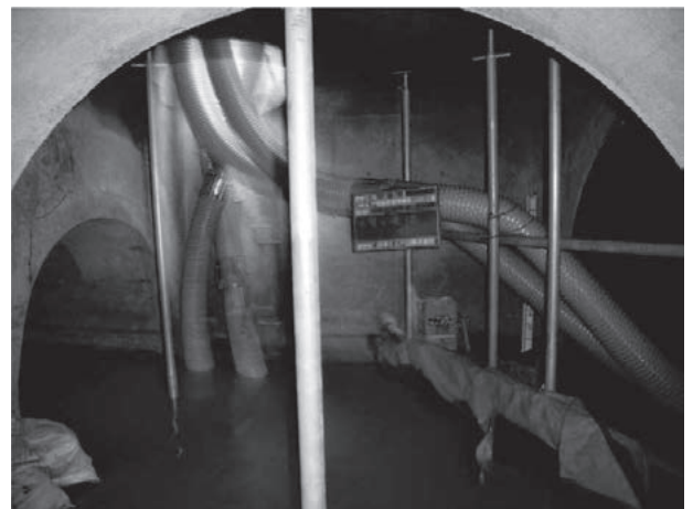
大口径更生工事 (φ2,000mm, 7m 3 /分)
