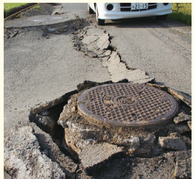
マンホール周辺で多数の隆起、沈下が発生（熊本県益城町）
