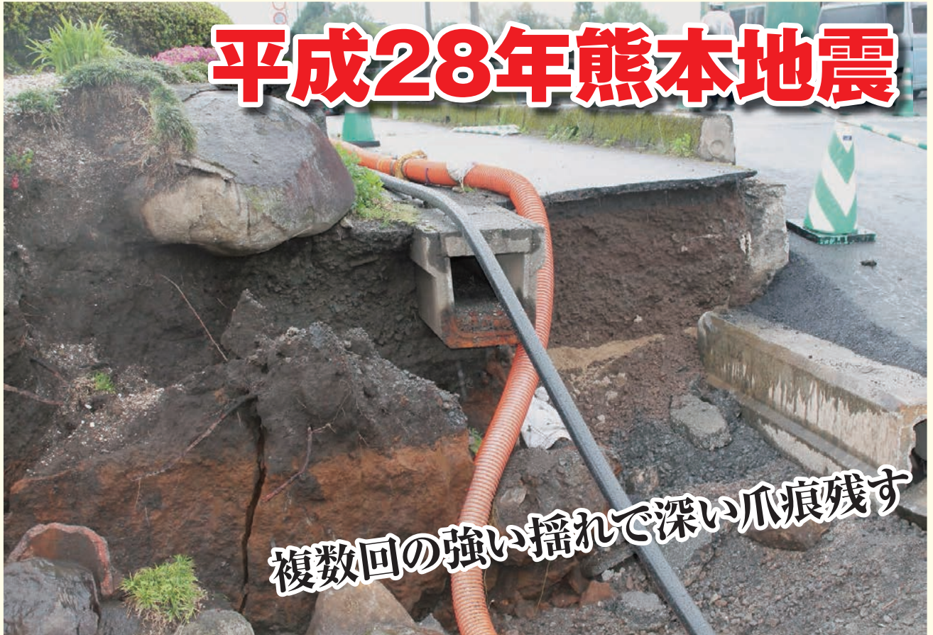
段差が発生した現場は仮設ポンプとバイパス管で対応（阿蘇市）
