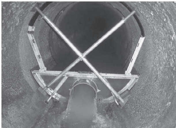
写真-1 止水板設置状況
