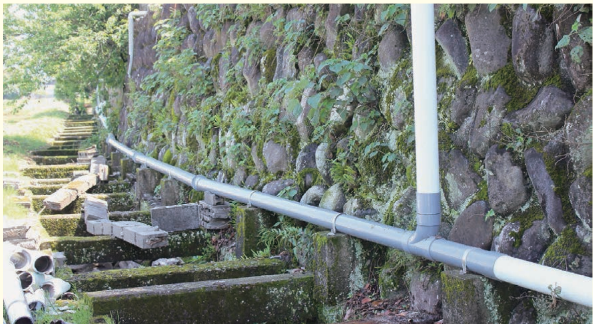
熊本県益城町ではクイックプロジェクトによる露出配管を導入していたが、被害は少なかった
