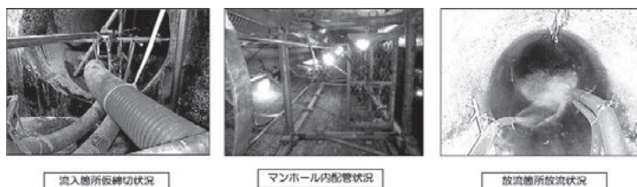
図-2 仮排水状況写真
