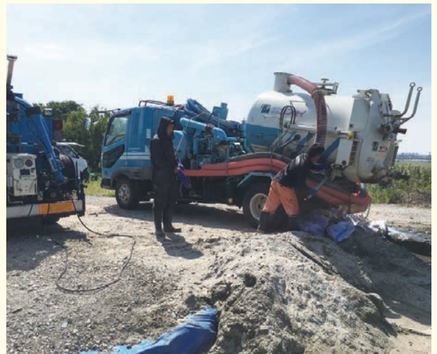
管内土砂の仮置場（熊本県益城町）
