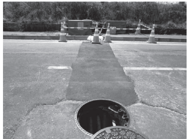
仮設ホースを埋設し交通規制なし
