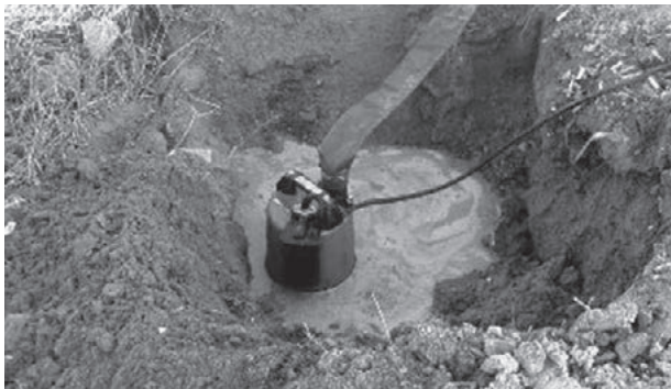
写真-1 釜場による水替えの例
