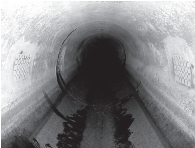
管更生施工の様子①
