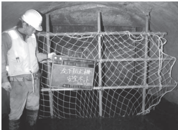
写真-1 流出防止柵・安全ネット
