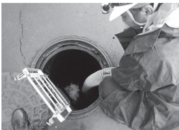
吸引作業中のマンホールの状況
