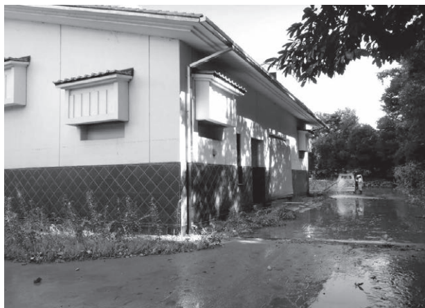
下妻中継ポンプ場（水が引いた状態）
