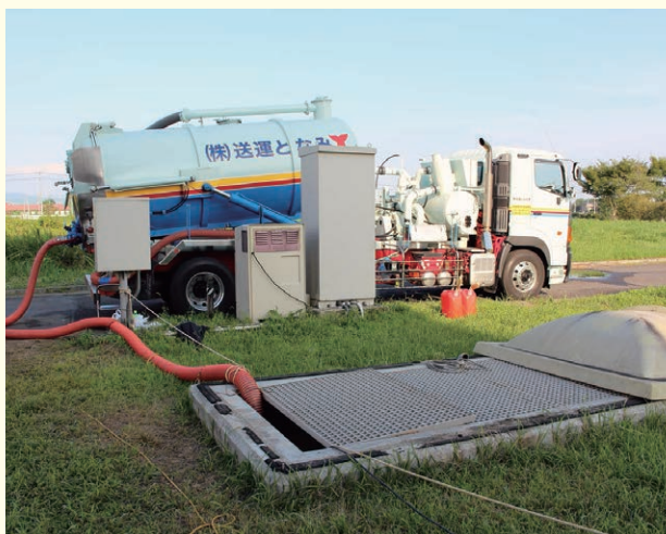
処理場の流入きょに汚水を搬送
