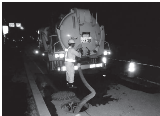
夜間作業の状況
