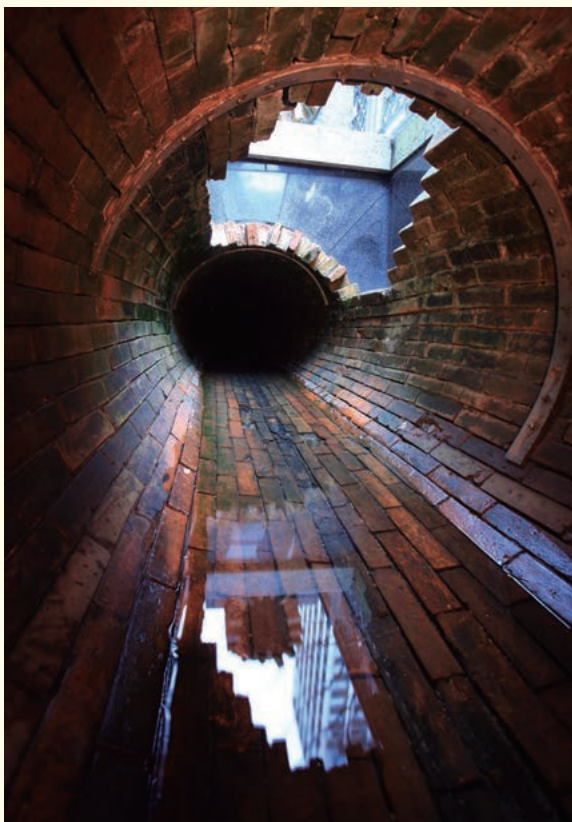
旧居留地煉瓦水路（神戸市中央区）
