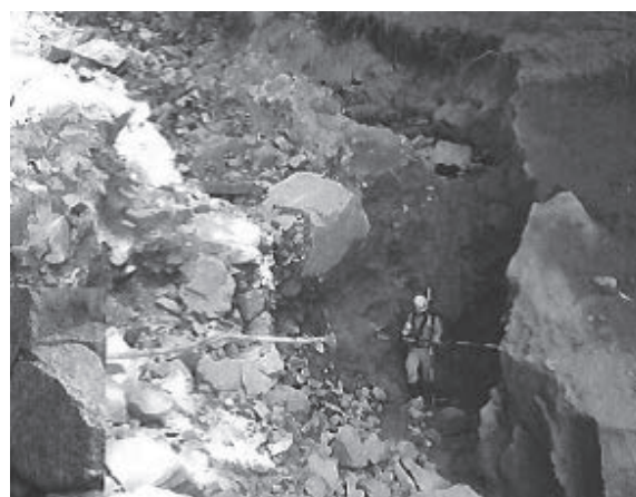
地山の一部分がえぐられた支流の状況
