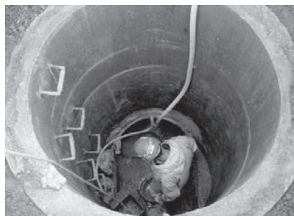
写真-7 グラウト注入状況
