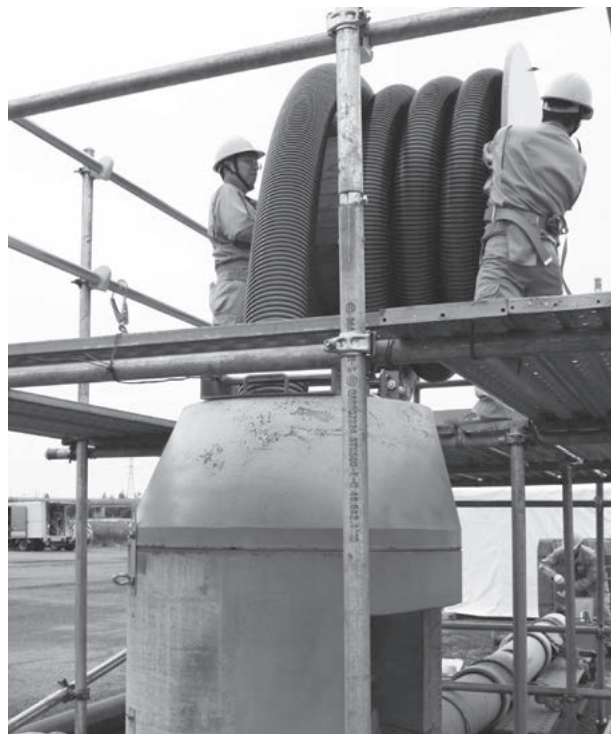
当協会主催の管更生技術施工展にも最新型の鞘管工法が出展
