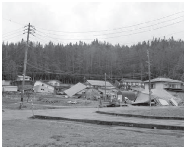
写真-8 家屋の倒壊
