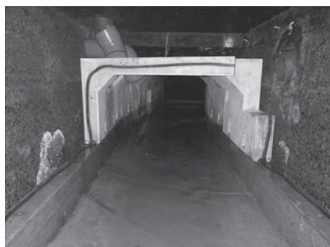
上ブロック施工状況
