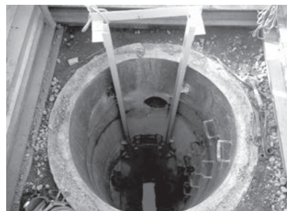
写真－3 レール等設置
