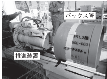
写真-4 推進装置・管の一体化
