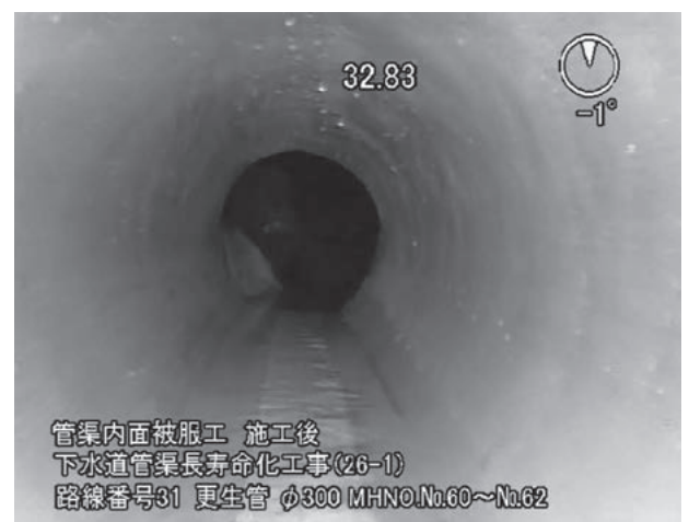
管更生後の管きょ
