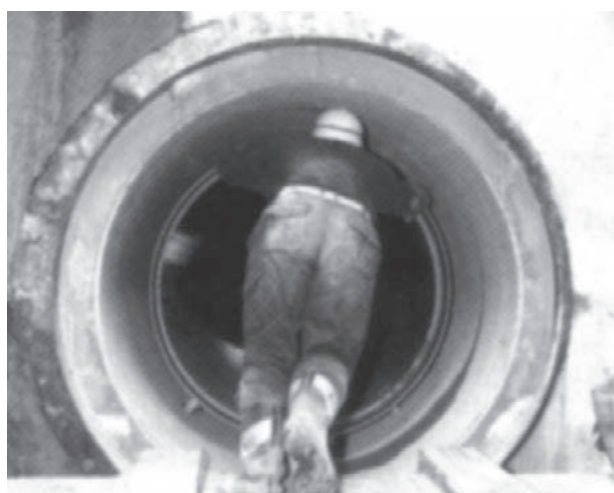
写真－1 強プラ管の運搬状況
