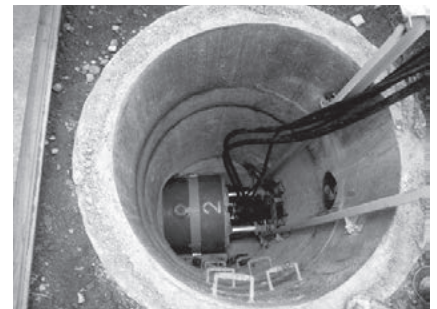
写真-6 バックス管推進
