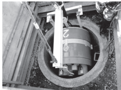
写真-5 推進装置・管の投入
