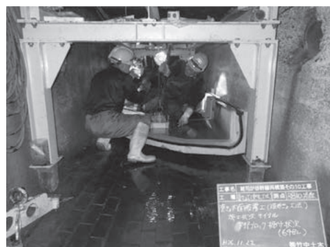
下ブロック施工状況
