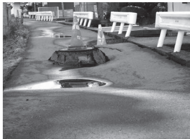
写真-2 マンホールの隆起 (花巻市)
