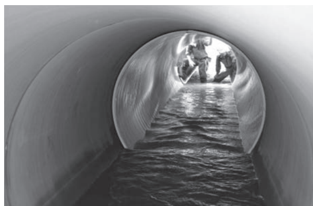
供用下における施工状況
