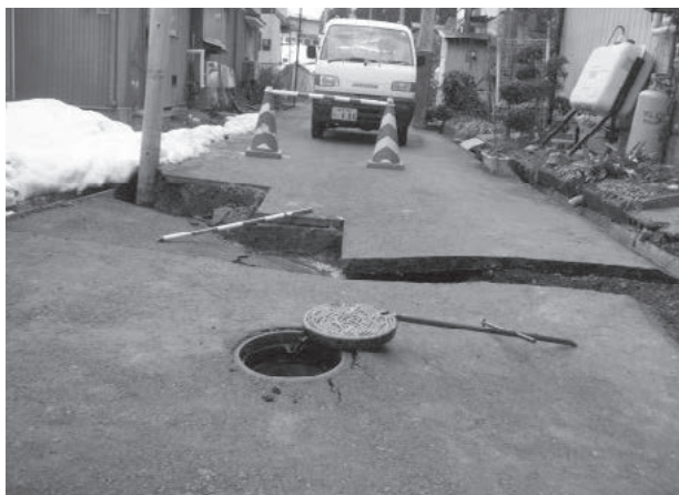
写真-1 管路の沈下 (花巻市)
