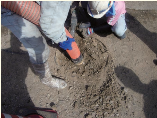
土砂が管内に流入、ポンプで吸引作業を行う（下）
