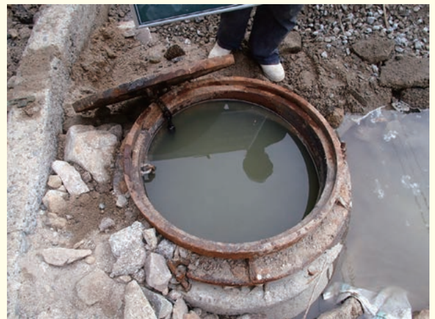
下水道が機能不全状態に
