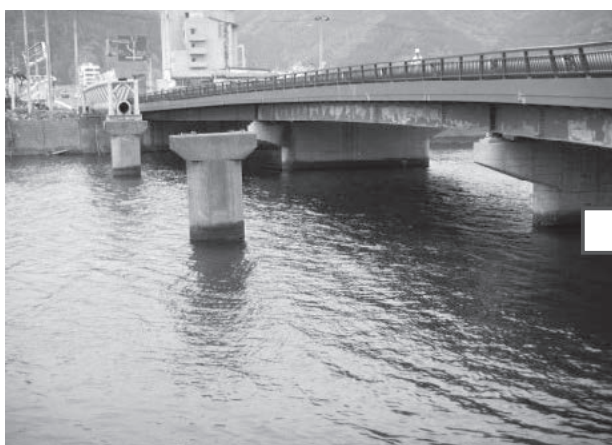
写真-3 水管橋の流失 (釜石市)
