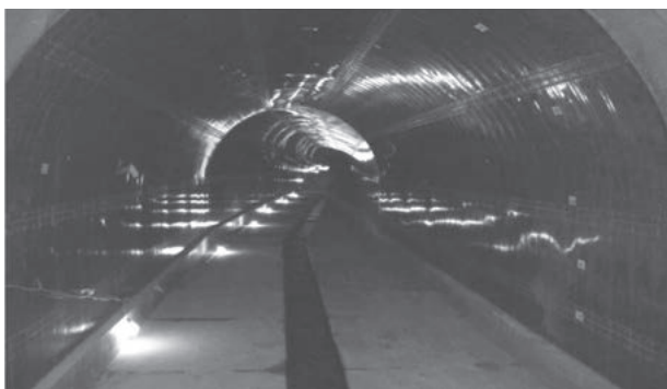
施工例・馬蹄きょ（内寸法3000×2900）
