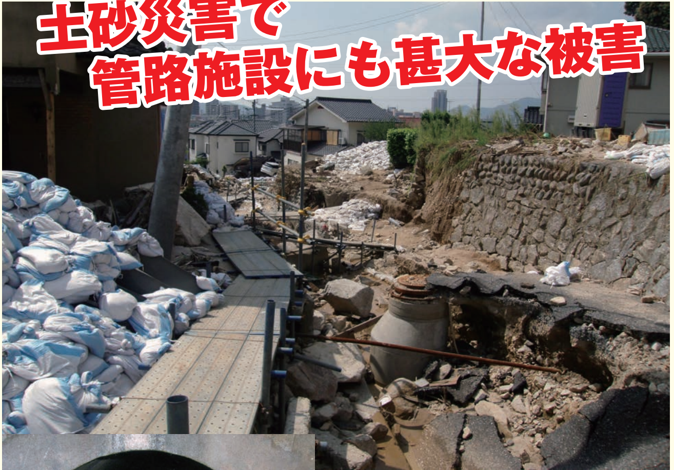
マンホールも地上に見える状態に
