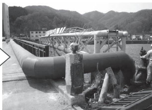
写真-4 仮設配管状況 (釜石市)
