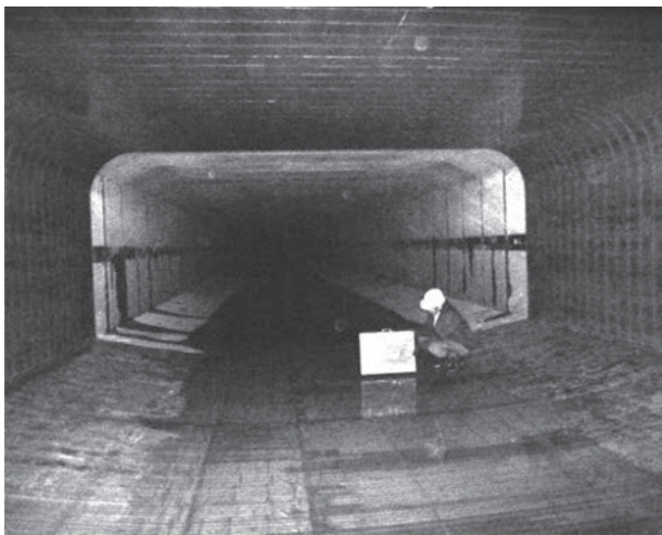
施工例・矩形きょ（内寸法6200×3000）
