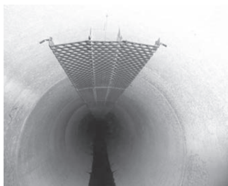
写真-2 スペーサーとその取付け状況
