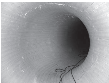
曲線施工の施工例
