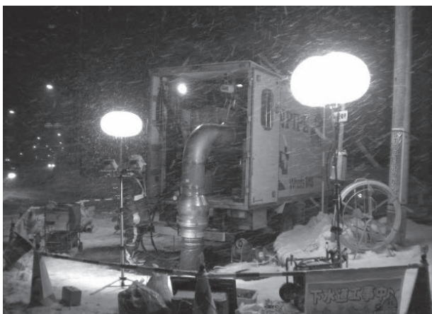
写真2 寒冷地での施工
