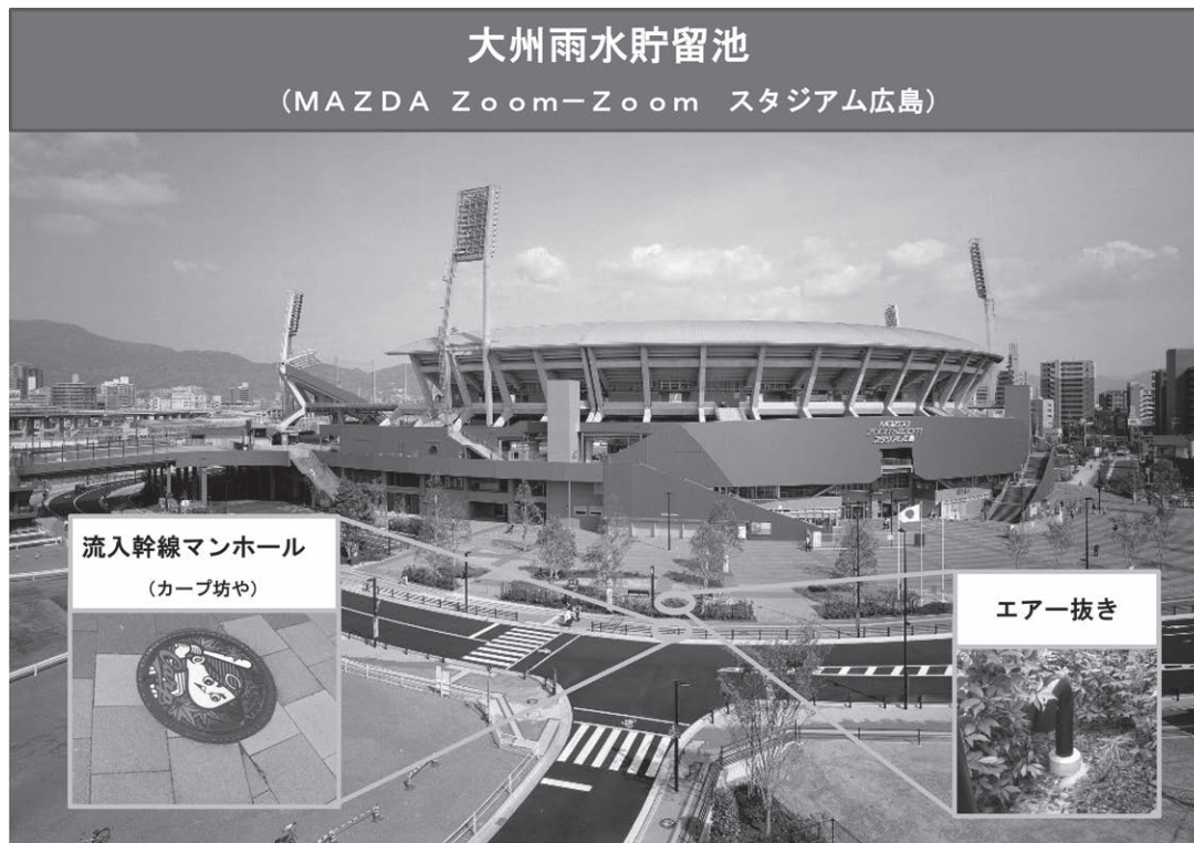
広島市の大州雨水貯留池での対策
