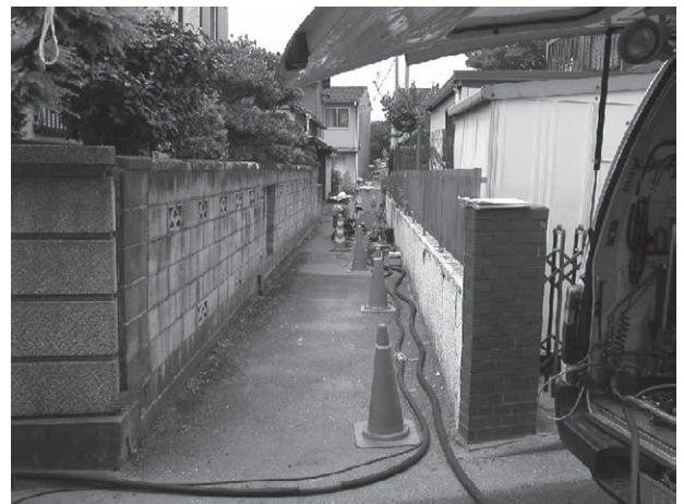
コンパクトな施工車からホースをつなぎ、距離のある現場に対応 (M市)
