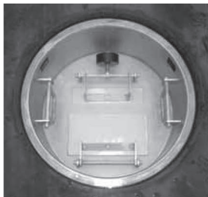
東京都が導入している飛散防止マンホール蓋・GLV
