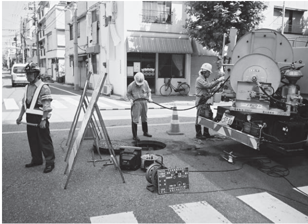
作業帯の設置と誘導員の配置
