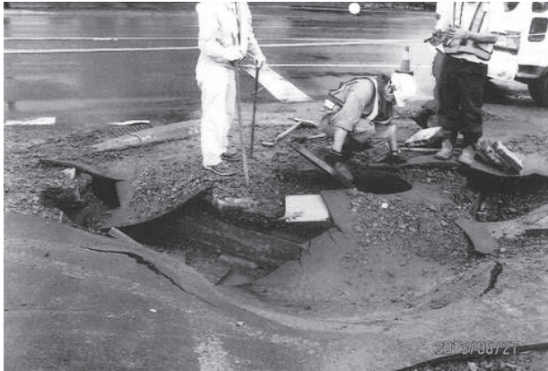
10分間に12.5mmの局所的な降雨があり歩道部分が損壊 (H25.8.27札幌市西区発寒)
