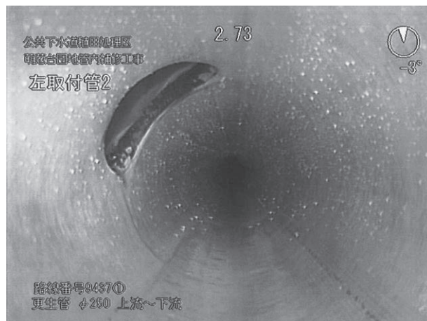
管更生施工後
