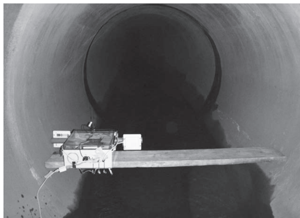
メッシュルータの設置例（伊勢山辺雨水幹線）
