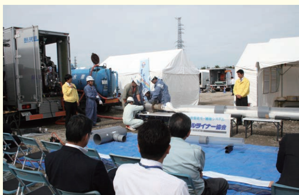
それぞれの工法が趣向を凝らしたデモ施工を展開した
