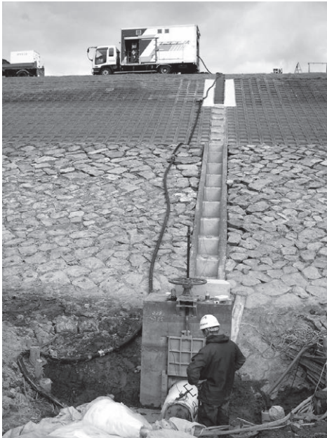
池底ひ管の施工状況 (K市)
