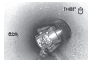
図-5-② ブラシで孔を削り 仕上げている状況
