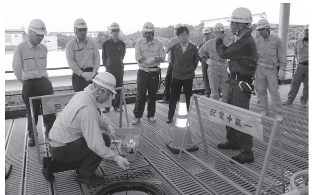
ガス検知器で事前確認
