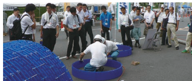
下水道展2013東京で実施された大規模なデモ施工展示
