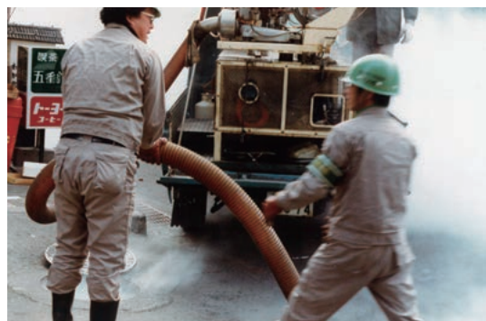
パッカー工法による薬液注入作業
