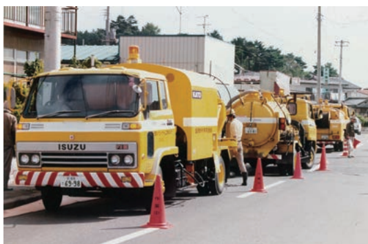
昭和60年代当時の管内清掃作業の状況
