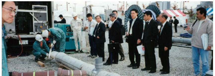
大阪市で開催された下水道管更生技術デモ施工展の様相 (H14.11)
