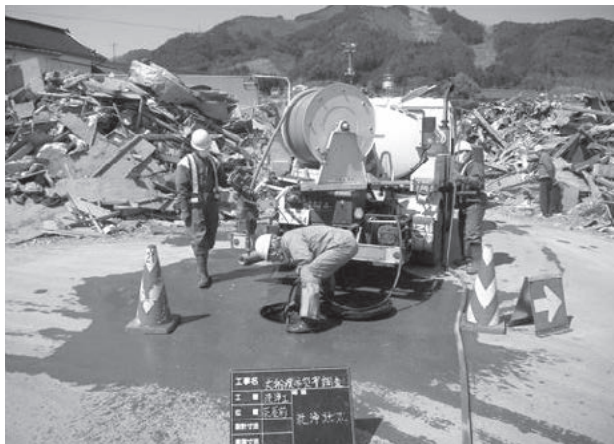
東日本大震災で被災した管路内の清掃の状況
