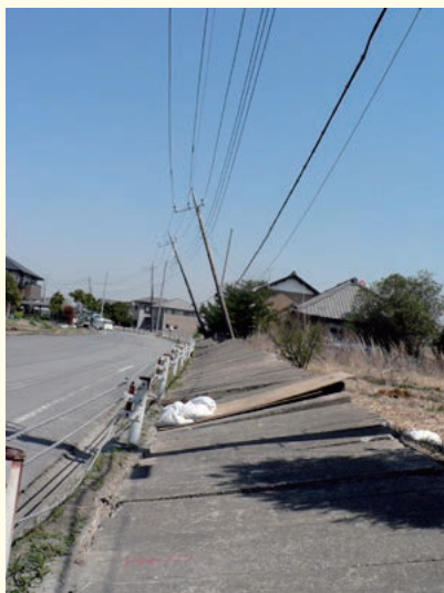
潮来市の日の出地区は地区全体が液状化の被害に遭い、 家屋や電柱などが至るところで傾きました
