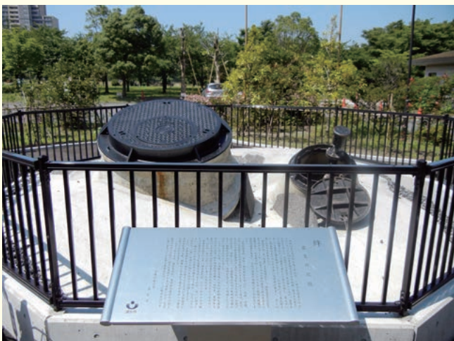
高洲中央公園には、液状化で浮上した耐震性緊急貯水槽が震災の教訓を伝えるモニュメントとして保存されています
