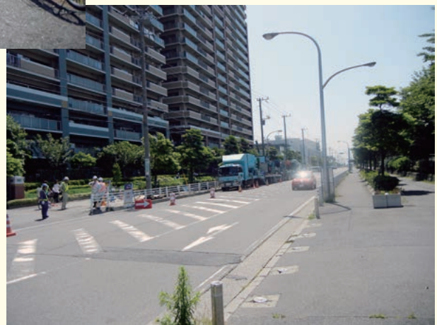
近辺では同様の布設替え工事が実施されています
