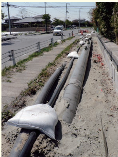
典型的な砂地盤であったため、埋設してあった 水道管や下水道管が浮上したところもありました
