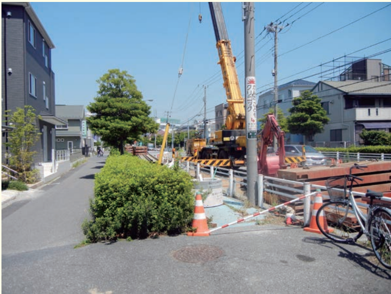
現在は、車道に新設の下水道幹線を築造する工事が進行中
