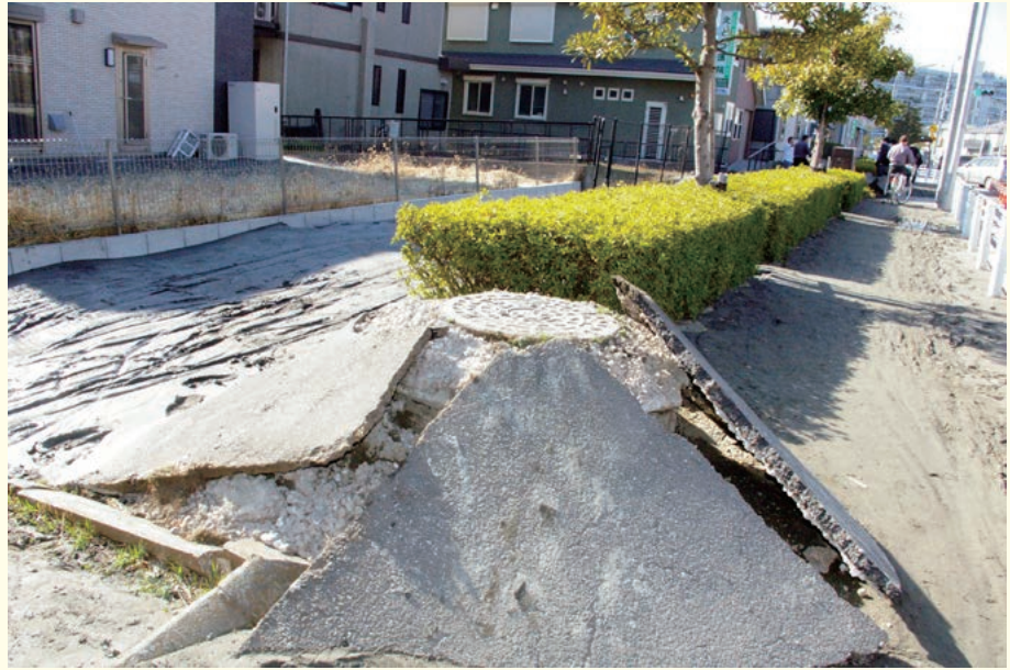
高洲中央公園前の歩道は被害の最も大きかった場所でした
