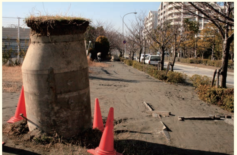
TVニュースにも採り上げられた浦安市の明海小学校裏のマンホール
