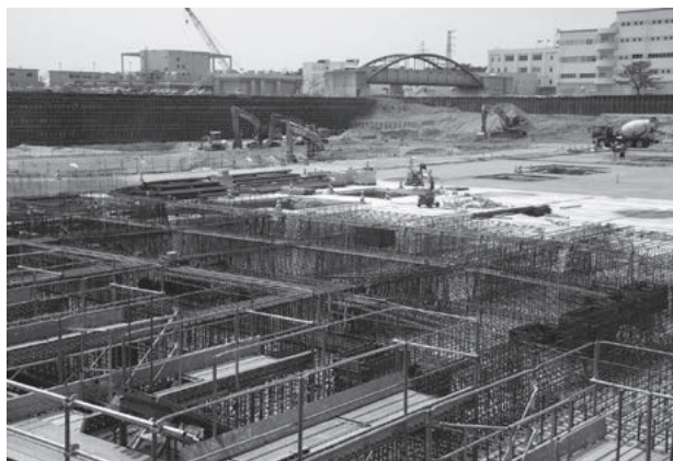
着々と本復旧が進む南蒲生浄化センターの水処理施設
