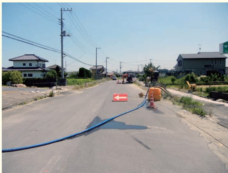
現在では下水道の復旧工事はほぼ完了し、 水道管の耐震化を図る本復旧工事が進められています
