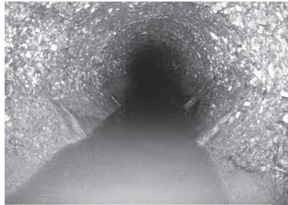
施工前管内腐食 φ 500 mm
