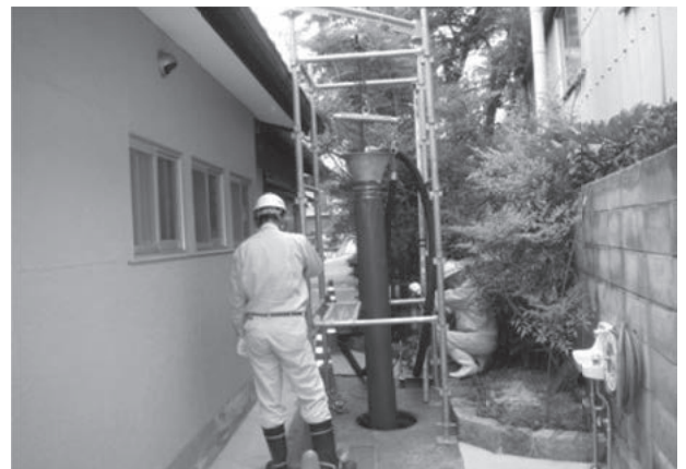
狭所現場での施工
