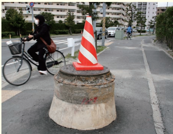
URマリナースト21フォーラム脇の歩道 通行する人たちの障害になっていたマンホール
