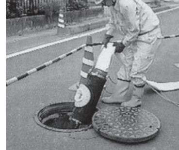
取付け管反転装置セット状況
