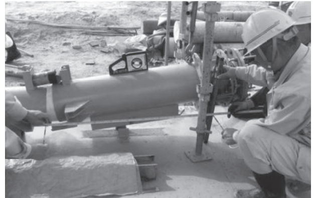
地盤変位に伴う既設管への追従性試験
