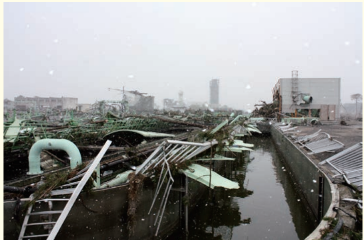
瓦礫の山だった水処理施設
