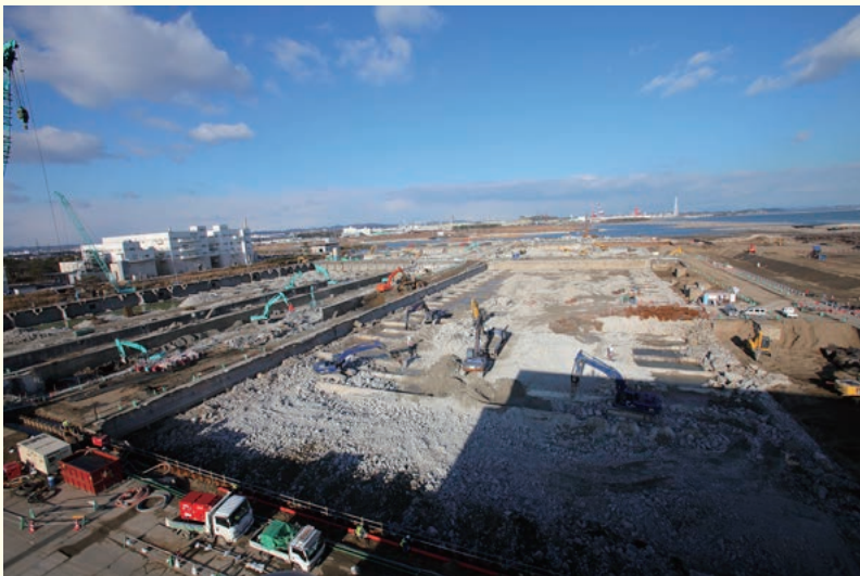
解体工事が進む水処理施設
