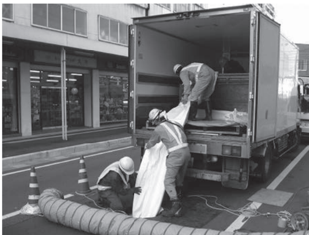
形成工法施工状況
