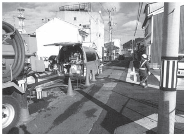
写真－2 本管TVカメラ調査の状況
