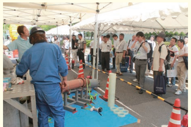
下水道展では初となるデモ施工は注目の的に
