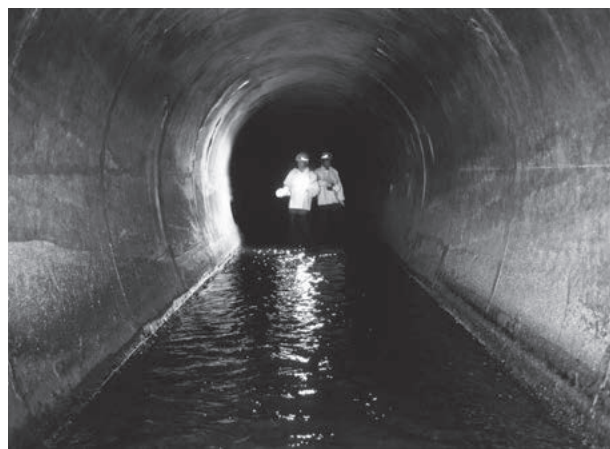
写真-1 目視による管内点検の状況
