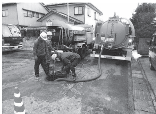
写真－1 高圧洗浄作業の状況
