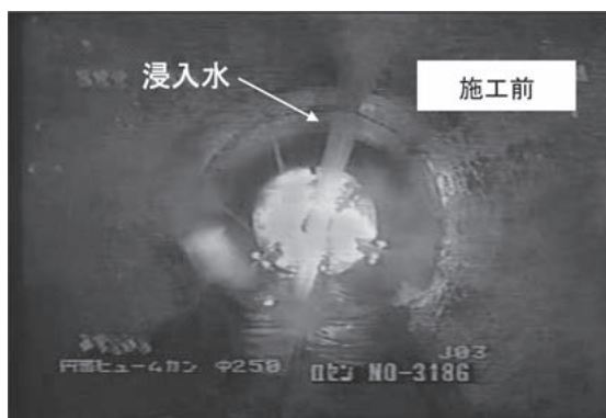
施工前管内状況
