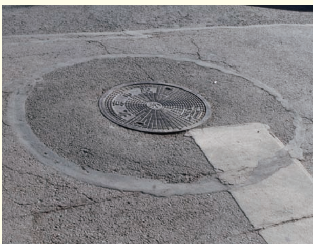
蓋の取替も日本と同様路盤を円形にカットする技術が多用されている
