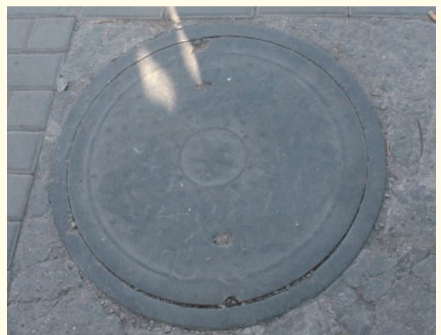
天安門広場近くでは、古いマンホールが多い。中央には中国共産党を表す星のマークが
