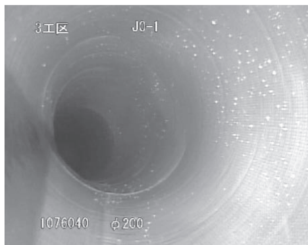
口径200mm陶管の破損(上)と補修後(下)
