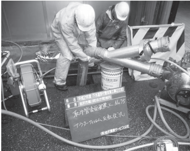
取付管更生工事の状況
