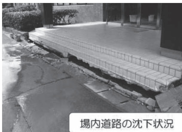
西方沖地震の被害
