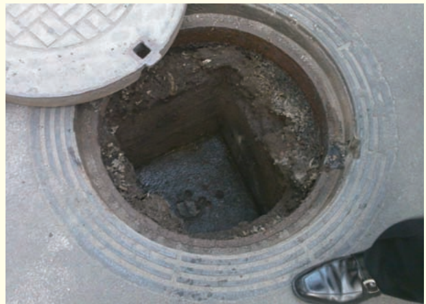
マンホールを開けたら、中が矩形になっていてびっくり
