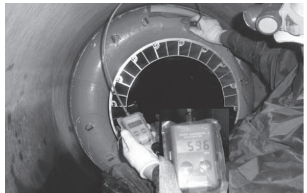
③機材にエアを充填し、規定圧力で養生
