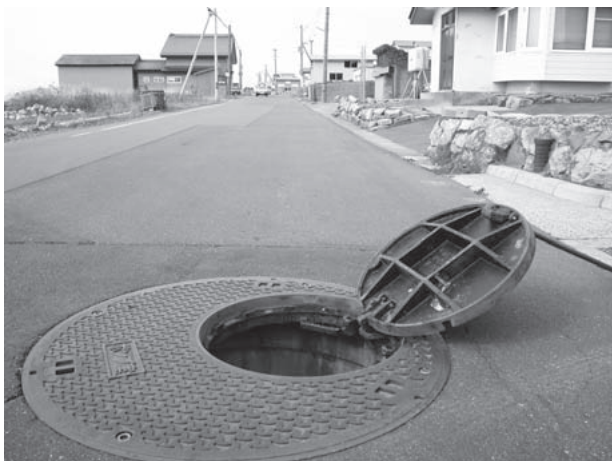
マンホールポンプの維持管理用に設置された 600/1200の親子マンホール
