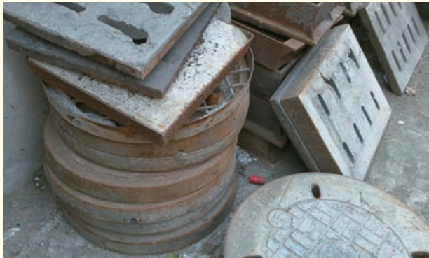
道路に野積みになったマンホールや側溝の蓋。コンクリート製品が多い
