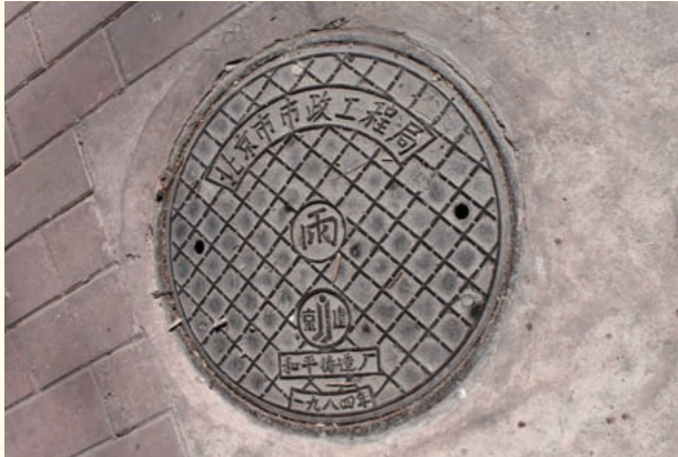
雨水管のマンホール蓋。1980年代から管路の整備率が上昇を始めた。この蓋はその当時のなごり
