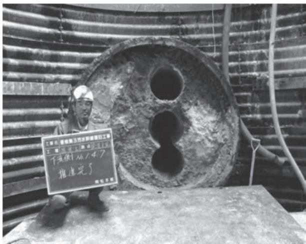
コンクリート破砕（推進工法）
