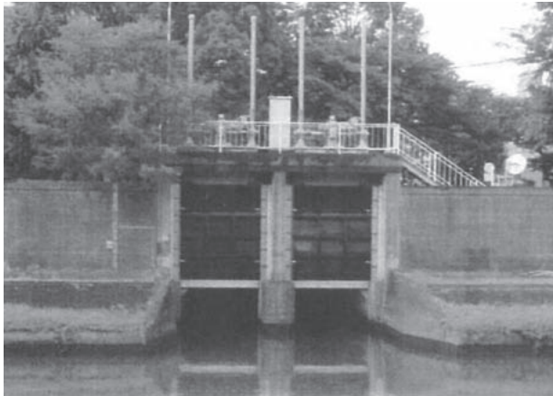
高潮防潮扉の例
