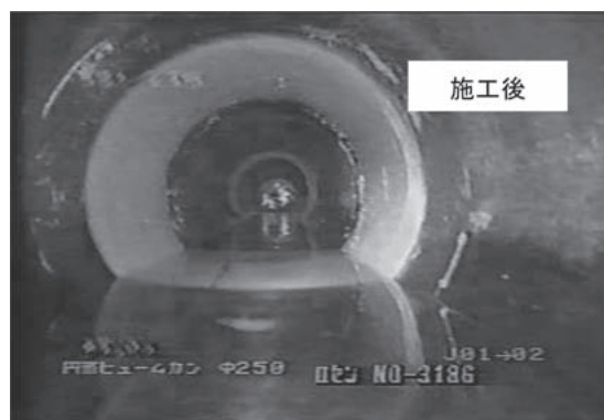
施工後管内状況
