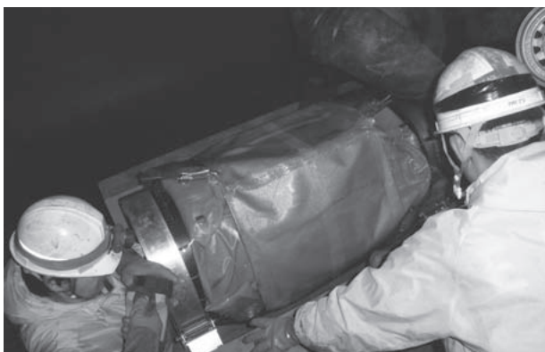
②含浸したパックを補修機材に巻付け補修位置へ搬入
