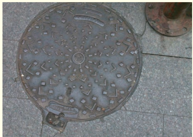
不思議な鍵付きマンホール。開けられた形跡はない
