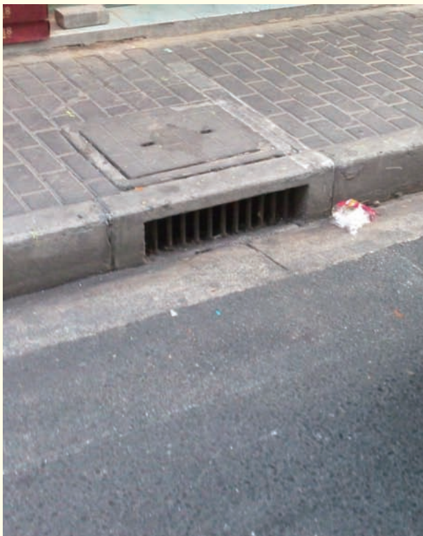
歩道に設置された雨水排水口は、ヨーロッパで見かける物とほぼ同じ
