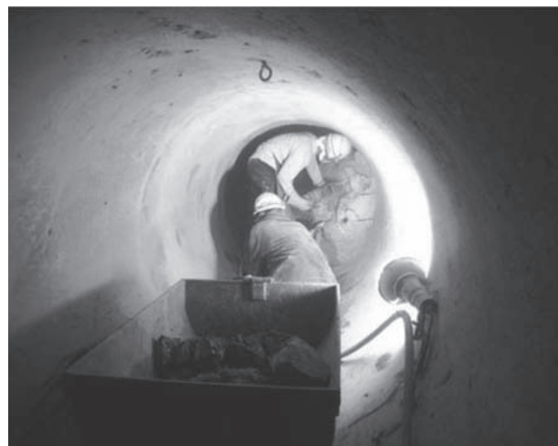
コンクリート破砕（人力）
