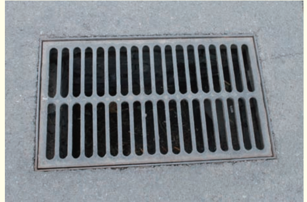
雨水排水口のグレーチングは日本の物と同じだが、泥溜めが清掃された痕跡がない
