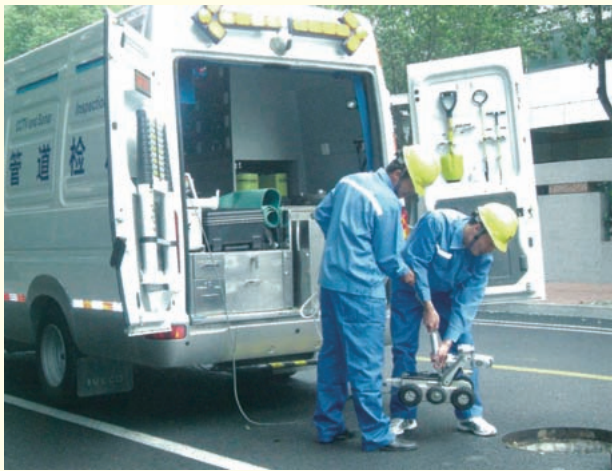
最新機器を使ったTVカメラによる調査は頻繁に行われるようになってきている
