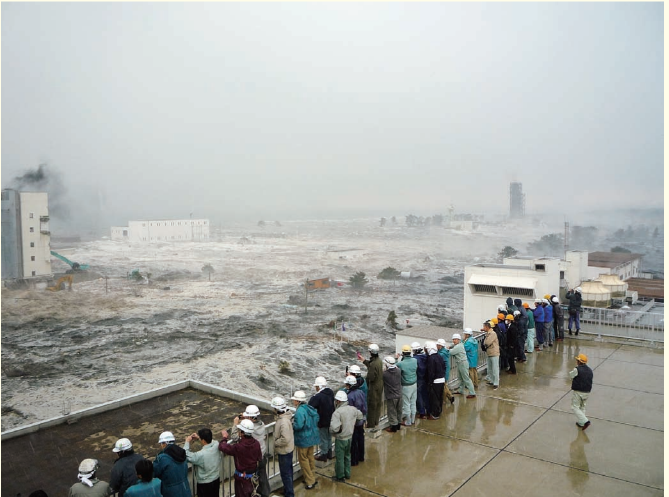
大津波に水処理施設が飲み込まれる仙台市の南蒲生浄化センター
