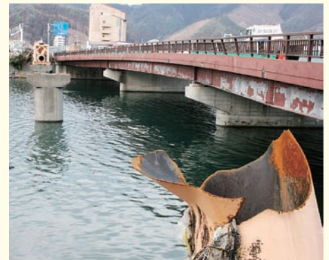
津波の勢いで引きちぎられた水管橋
