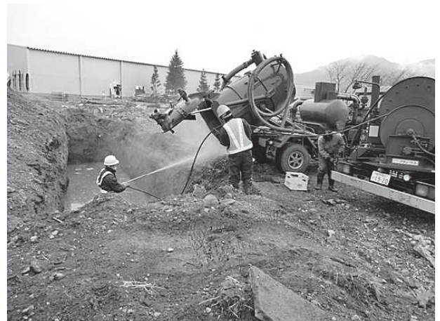
写真-3 大船渡市における吸引汚水の処分状況
