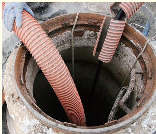
浮上したマンホールから洗浄ホースと吸引ホースを降ろす
