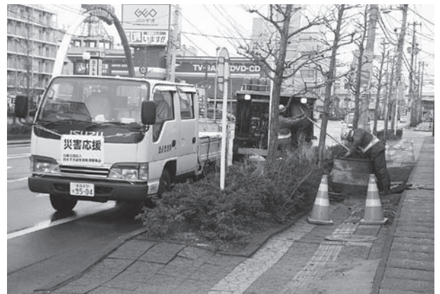
写真-10 大崎市における調査前洗浄作業
