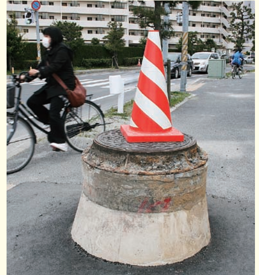
応急復旧が行われたマンホール（浦安市）
