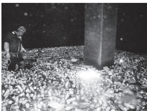
写真－６ 仙台新港背後地雨水幹線（缶ビールの流出状況）
