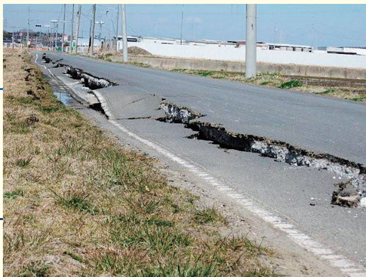
潮来市内では道路に大きな亀裂が入り通行を遮断した
