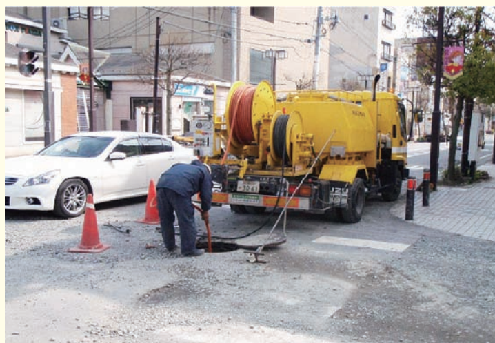
津波によって堆積した土砂を洗浄（石巻市内）
