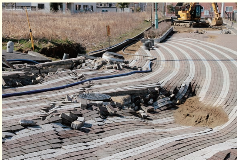
レンガが敷かれた歩道が陥没（神栖市）
