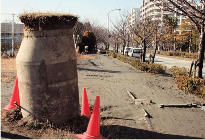
1 m以上も浮上したマンホール（千葉市）
