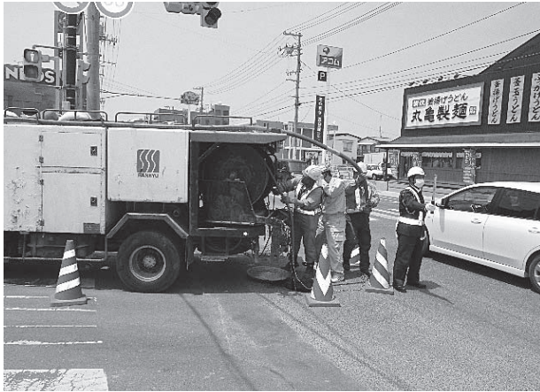
写真-7 石巻津波被災地域での洗浄作業
