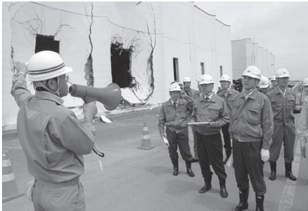
被災した仙台市の南蒲生浄化センターを視察
