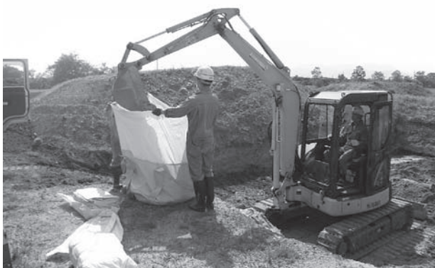
写真-13 福島県流域下水道土砂の仮置き
