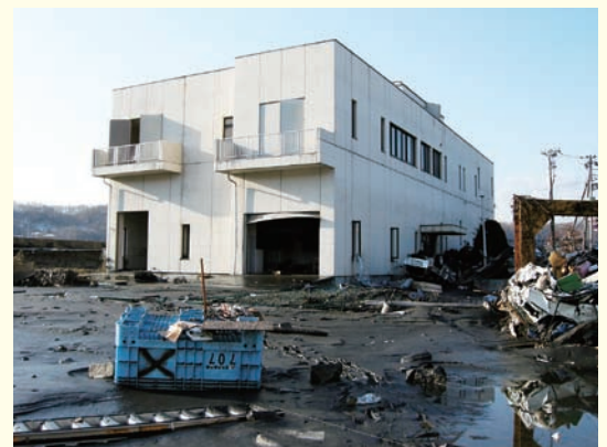
中継ポンプ場も多数被災した（宮古市）
