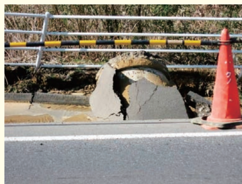
マンホールの浮上も所々で見られた
