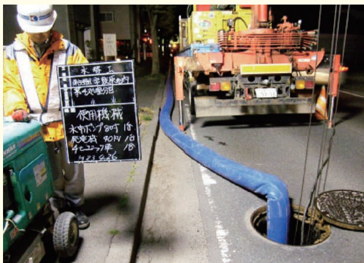
夜を徹して閉塞した管路の水替えを行う（福島市内）
