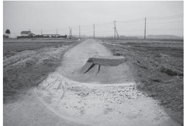
写真-3 浮上したマンホール
