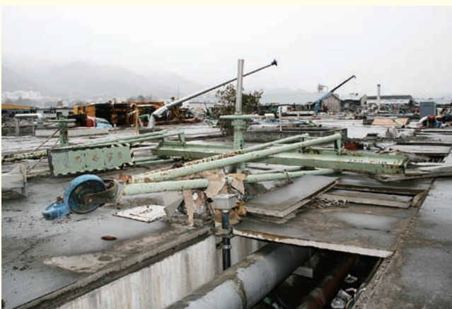
水圧で全ての物が同じ方向に折れ曲がっている（大船渡浄化センター）
