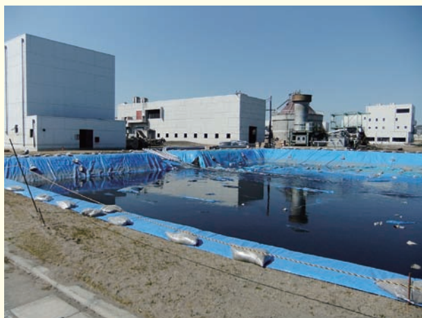
敷地を掘削して築造された緊急沈殿池
