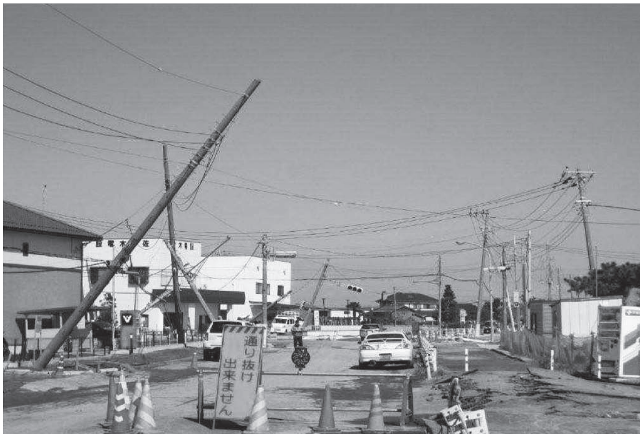
写真-2 茨城県水戸市内の被害状況
