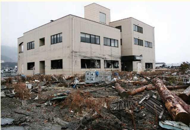
丸太や土砂によって埋め尽くされた大船渡浄化センターの管理棟
