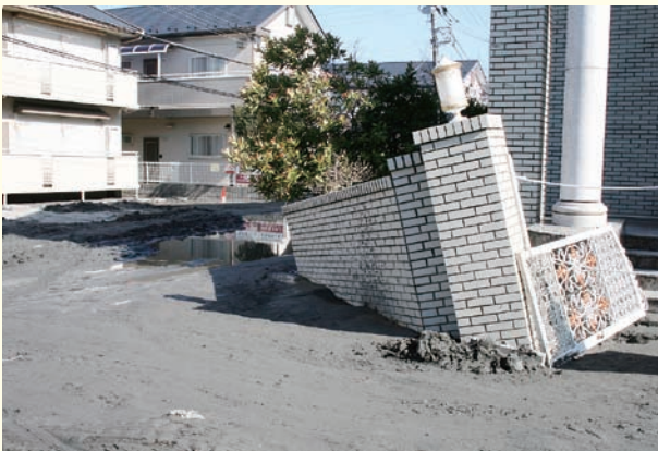
液状化で吹き出した砂と傾いた民家の塀（千葉市）
