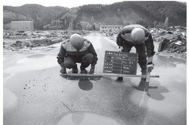
浮上したマンホールを調査（岩手県大槌町）
