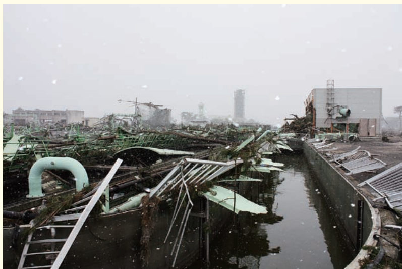
無残な姿に変わり果てた最初沈殿池
