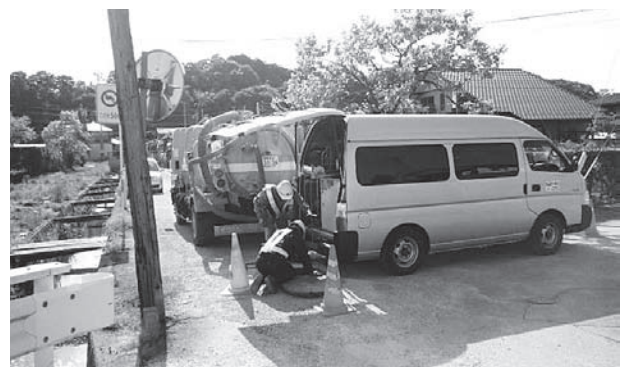
写真-11 山元町でのTVカメラ調査
