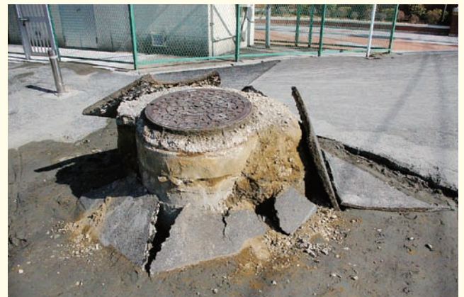
厚いアスファルトを破って浮上したマンホール（浦安市）
