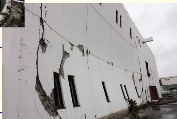
コンクリートの壁が津波の衝撃で押し曲げられた
