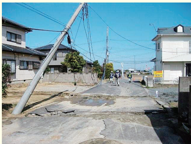
県内のいたるところで電柱が傾斜し、道路には土砂が吹き出した
