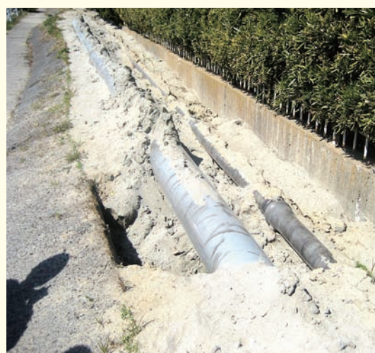
歩道下に布設されていた下水道管が浮上（潮来市）
