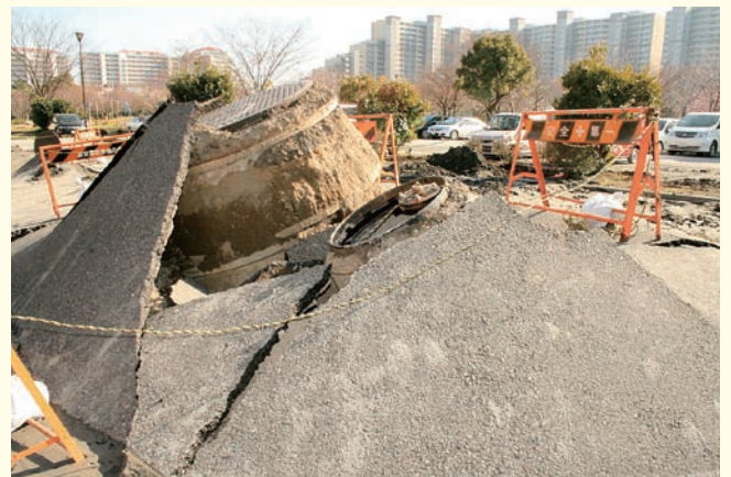
関東地方では液状化現象によって多くの被害が
