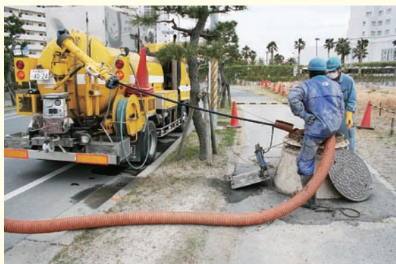
管路内の洗浄作業を行う（千葉市内）
