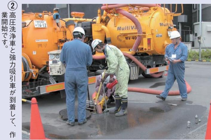
② 高圧洗浄車と強力吸引車が到着して、作業開始です。
