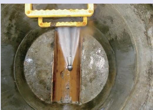
③ 高圧の水を後方に噴射するノズルを下流側マンホールから上流側に通します。
