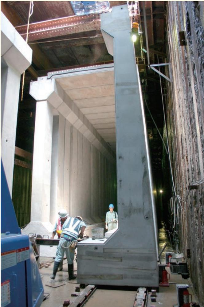
大雨による浸水被害を防止する雨水調整池の築造工事。狭い土地を有効活用し、さらに工期短縮を図るためプレキャスト式雨水地下貯留施設を導入
