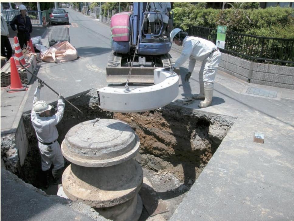
地震発生時にマンホールが浮上し、交通機能や救助活動にも影響を与えるため、浮上防止マンホールへの改造工事が各地で行われている
