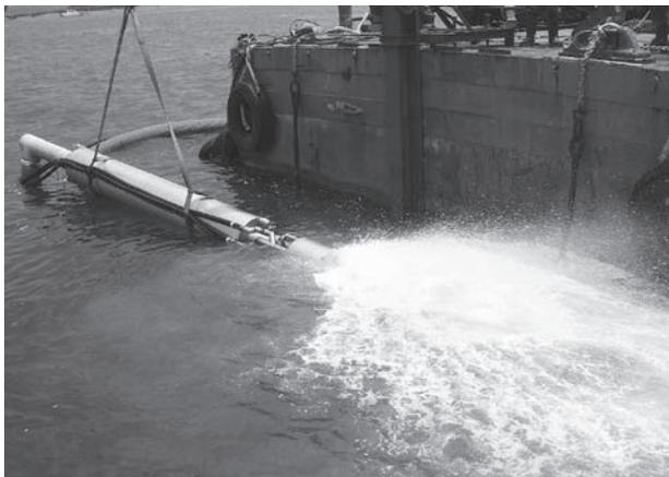
掘削ノズル噴射状況（松島港泊地浚渫工事）
