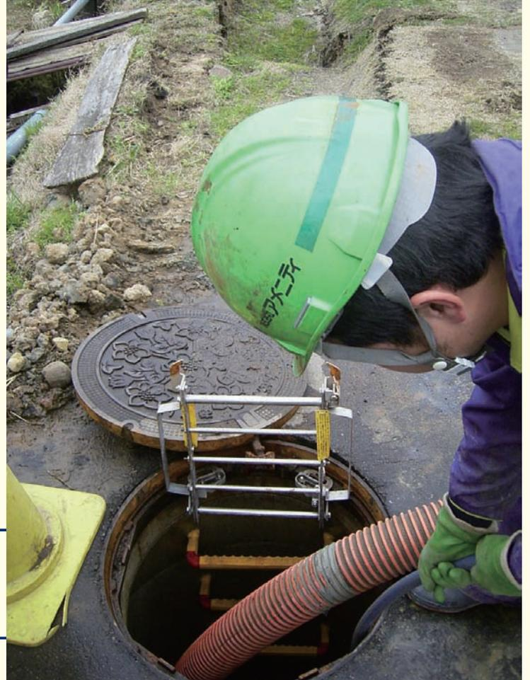
地震では下水道施設にも被害が発生する。管内の状況を調査するため、閉塞した管内の土砂を取り除く
