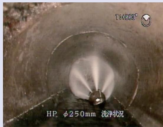
④ 今度は逆に下流側からホースを引張り、噴射で管内を洗いながら下流側マンホールに汚泥や土砂を運びます。
