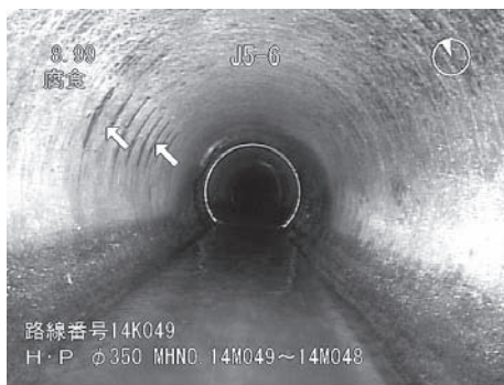
管の破損・腐食(左)
