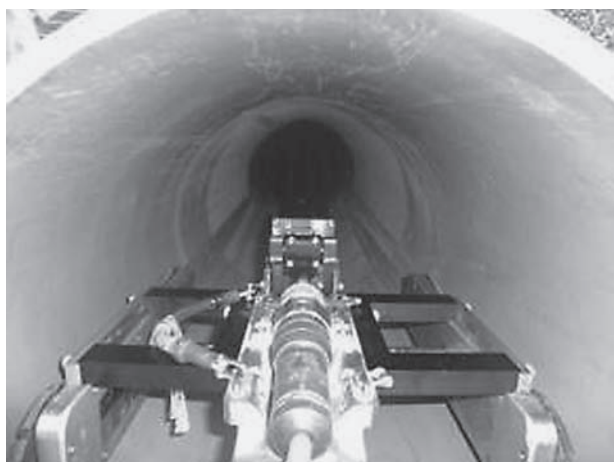
管内面計測状況
