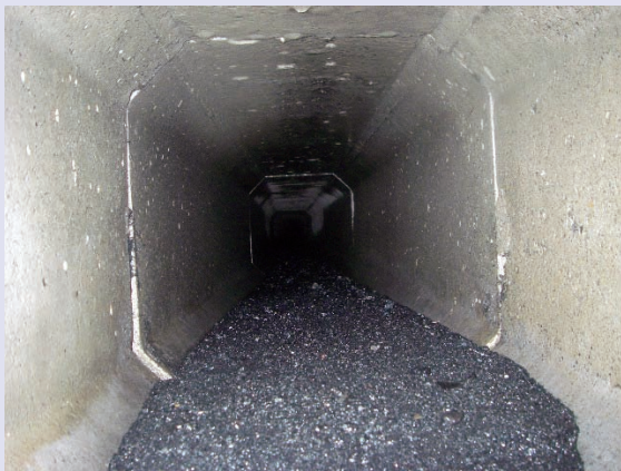
① 土砂が堆積したボックスカルバートの雨水管路。取り除くのは大変な労力を必要とします。
