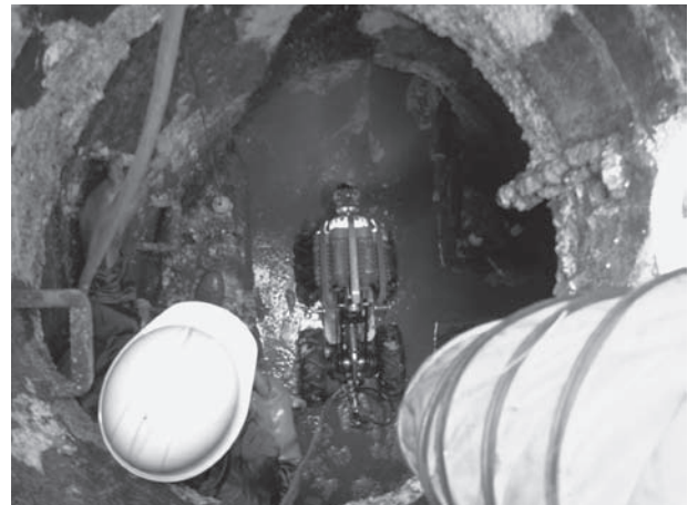
マンホールから発進
