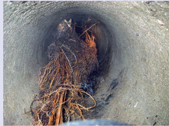
④ 亀裂部分から木の根が侵入し、管路をほとんど塞ぐようになっています。
