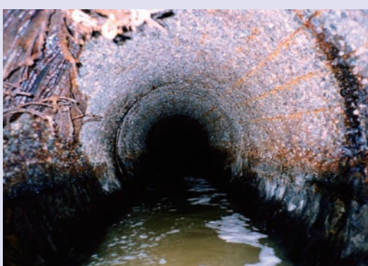
③ 老朽化によって管内がボロボロに。左上からは木の根の侵入も見られます。
