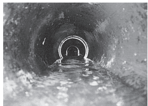
パイプハンターⅢで撮影した管内
