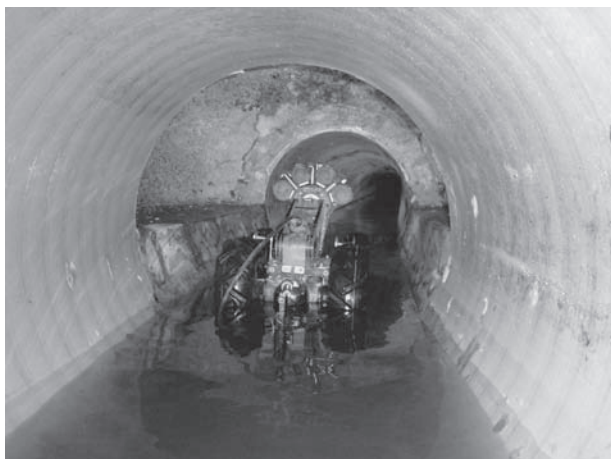
水量の多い管内を進むビーバーキャディ
