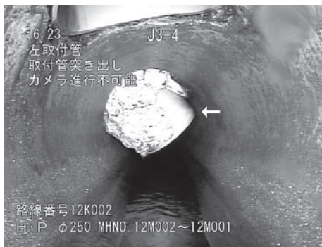
取付管の突出しおよび樹木根侵入(左)
