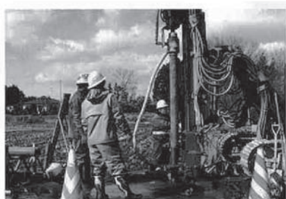
掘削状況(写真1)
