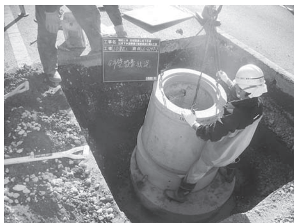
組立式マンホールの施工現場
