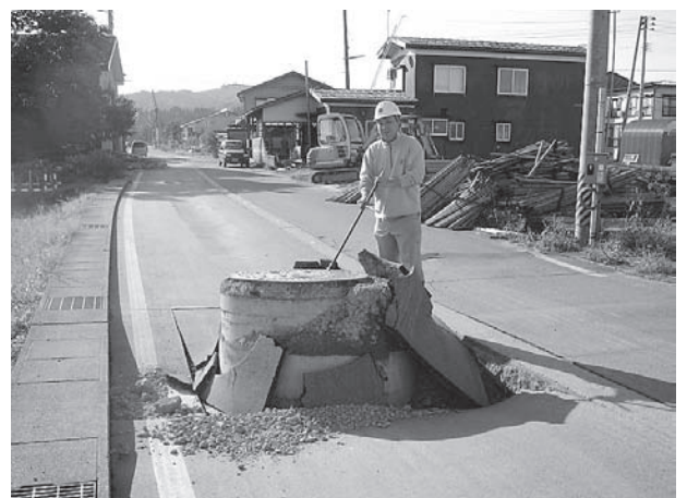
新潟県中越地震の時には数多くのマンホールが浮上した
