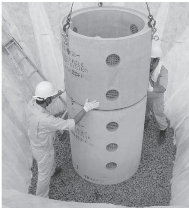
雨水を地中に戻し、浸水被害を軽減する 「浸透ラダホール」
