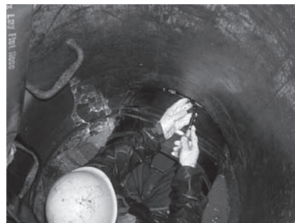
取り付け工事の状況
