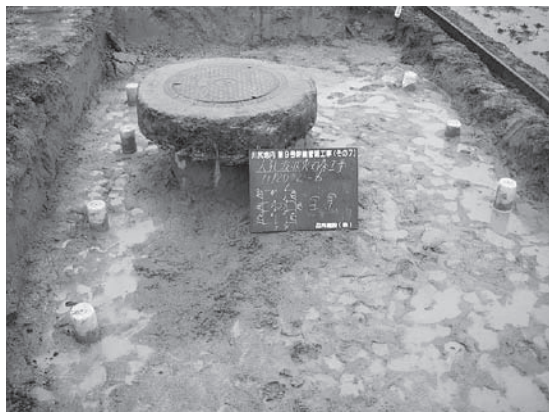
人孔部施工完了
