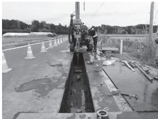
管路部施工状況
