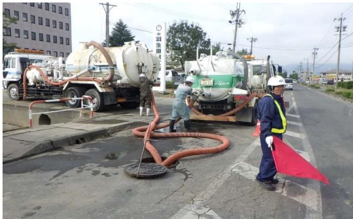
写真-5.3 2台の吸引車の協力による汚水輸送作業
