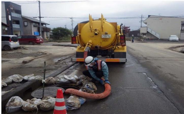
写真-5.2 溢水防止策を講じた汚水輸送作業
