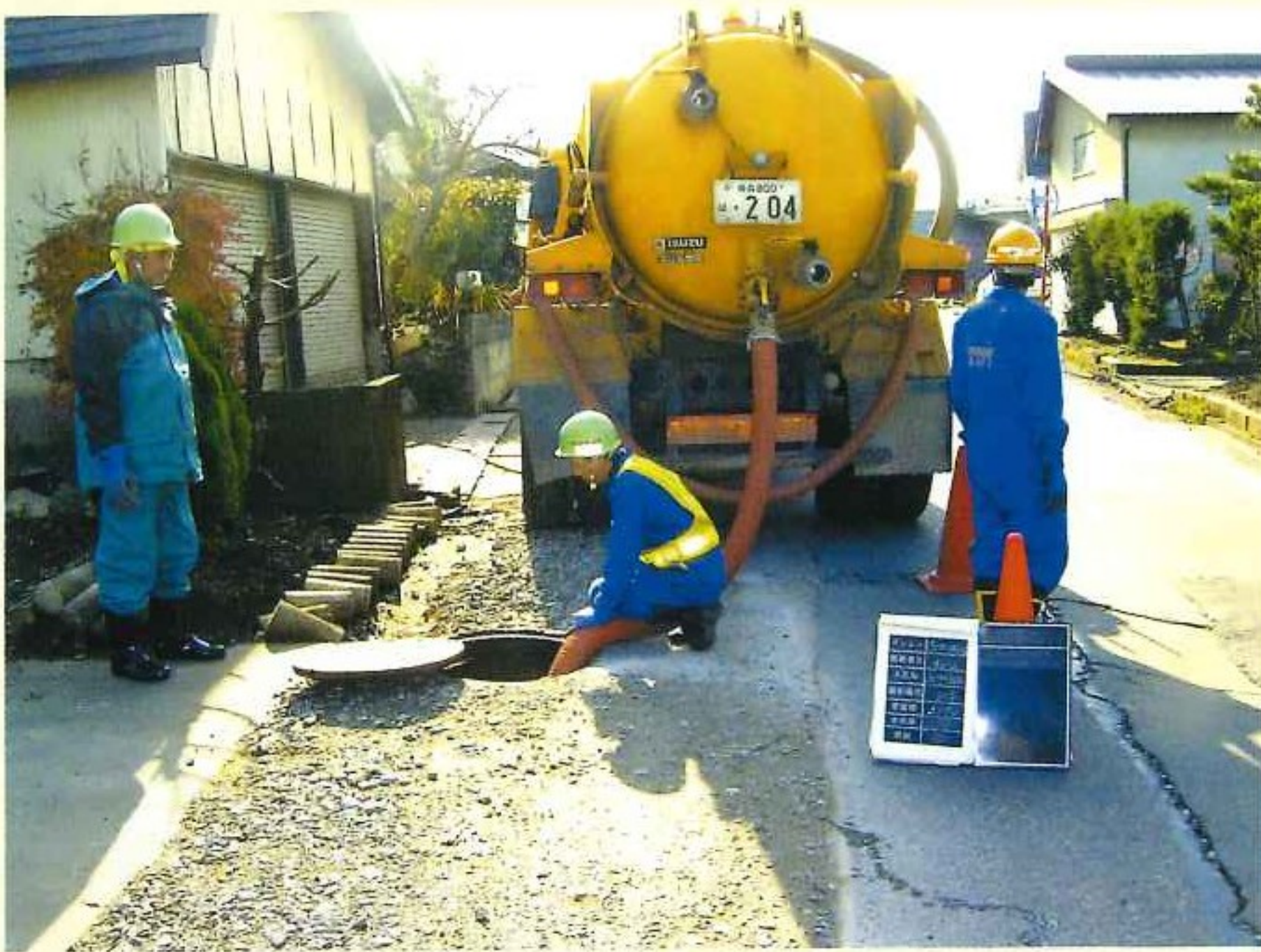
▲限られた場所での吸引作業
