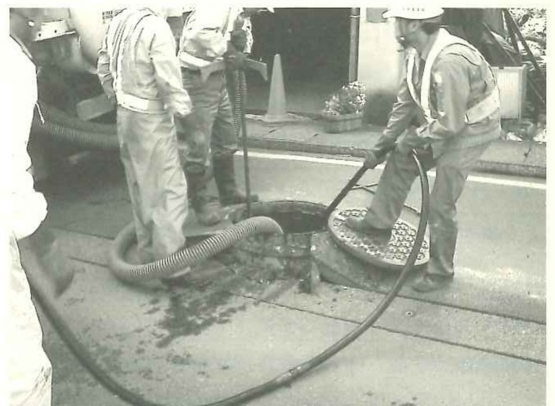
隆起したマンホールでの洗浄作業
