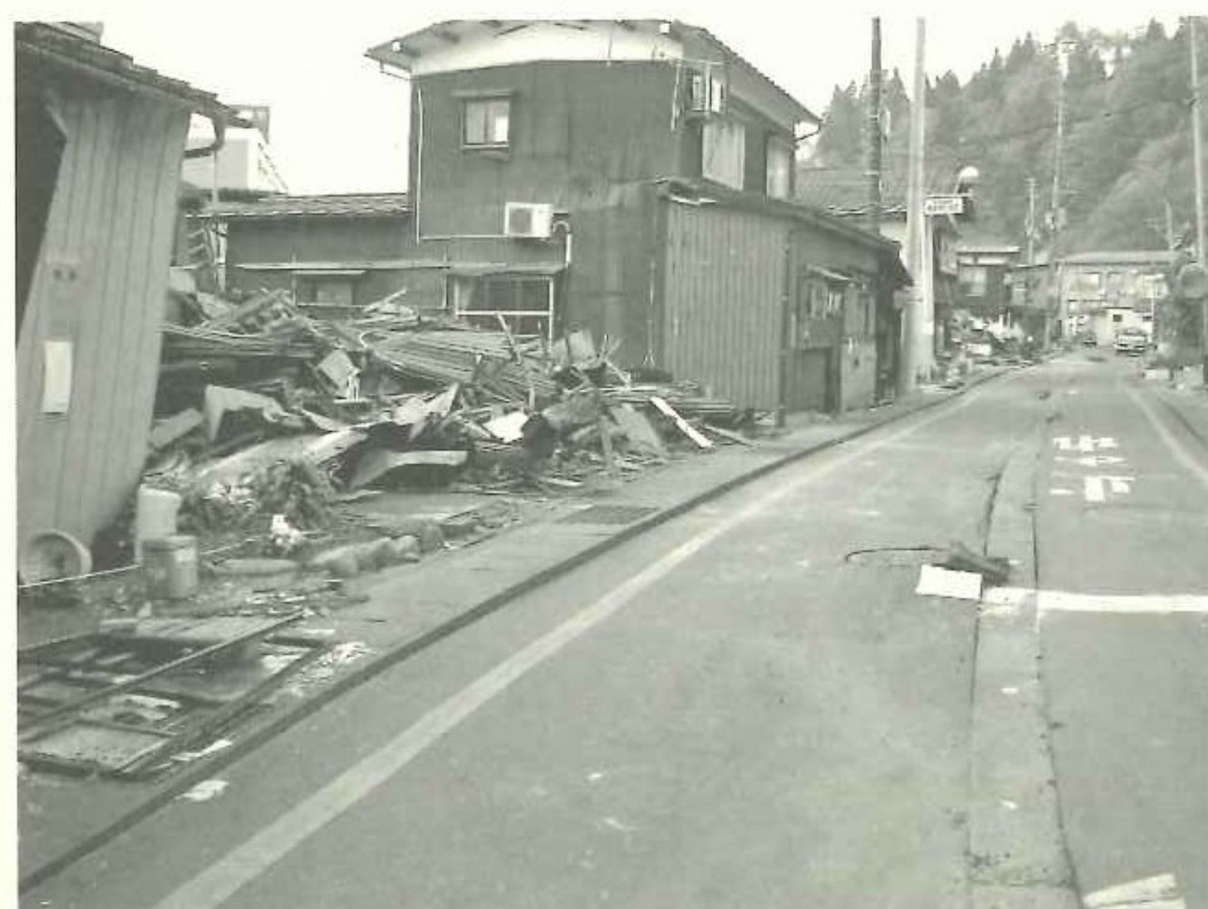
写真三 道路下の管きよ被害確認
