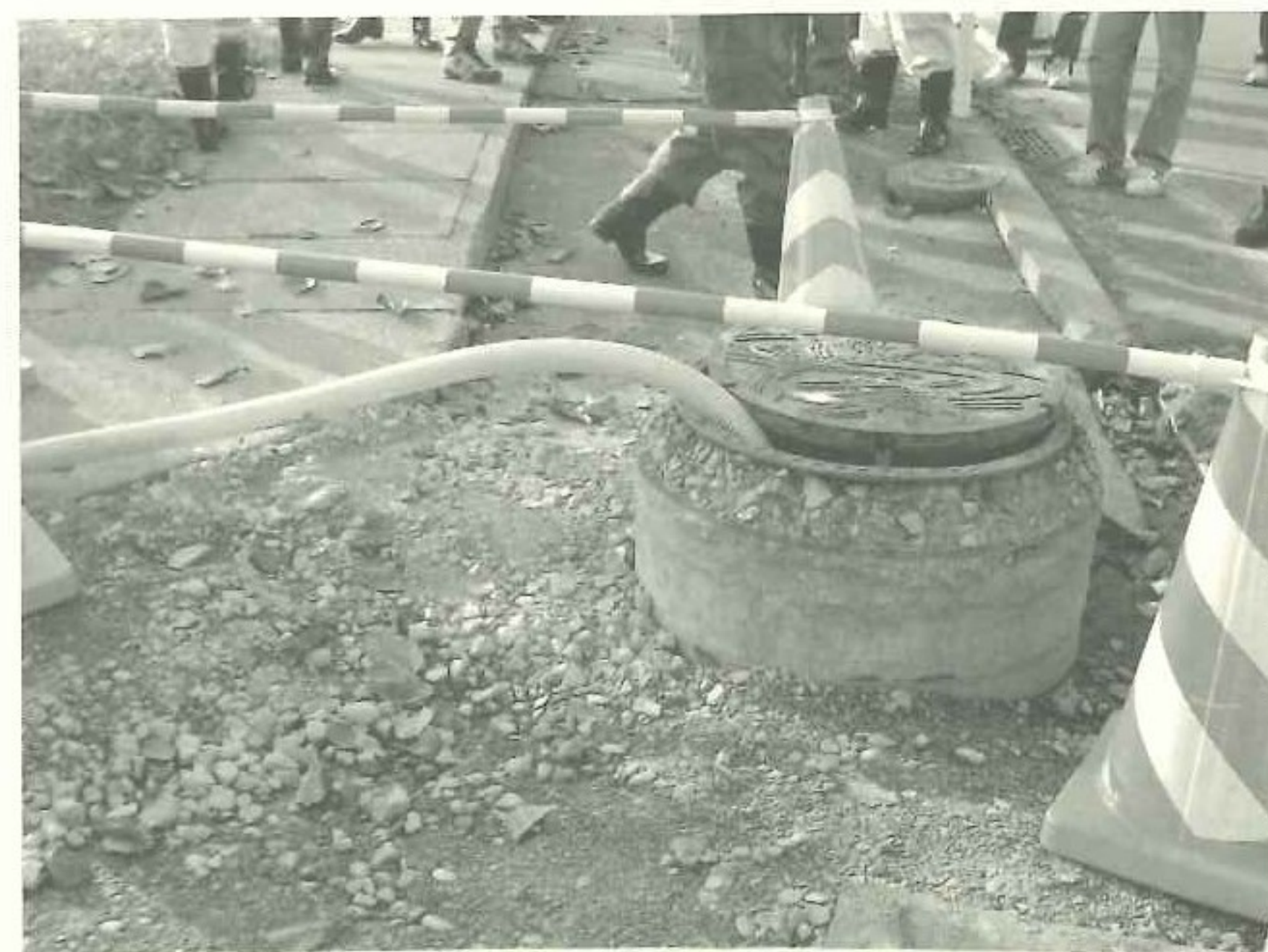
写真四 応急排水対策
