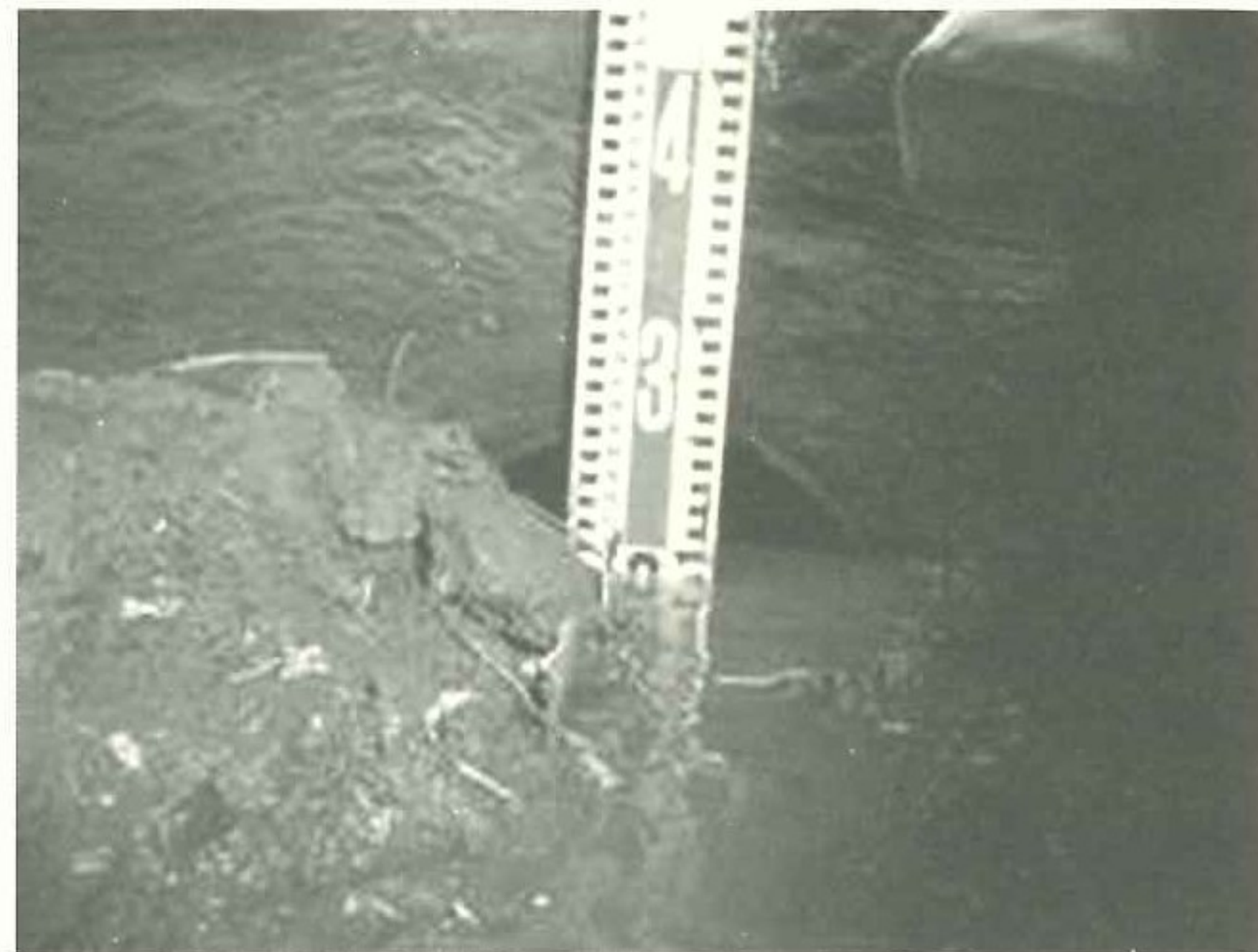
写真1、2 人孔内部の土砂堆積状況
