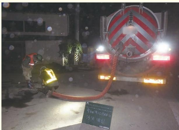
管内滞留汚水の吸引作業（長野県）
