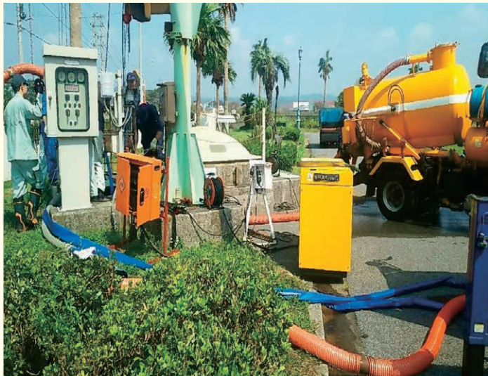
吸引用設備据え付け状況（館山市）
