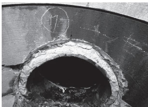
写真6 ヒューム管管口破損 (厚真町)
