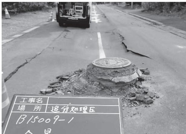
写真3 マンホールの突出 (安平町)
