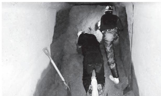
写真2 大口径雨水管土砂除去状況（広島市内）
