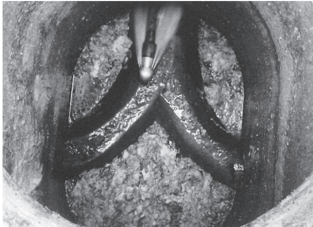
写真3 清掃作業状況
