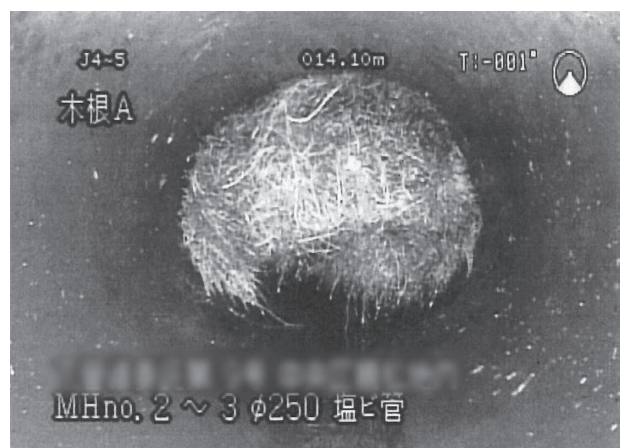
写真5 管内への木根侵入状況
