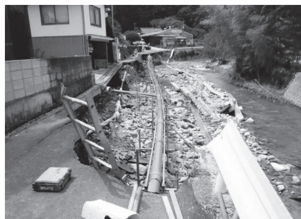
写真6 単管パイプを利用した仮復旧 ((左) 復旧前、(右) 復旧後)
