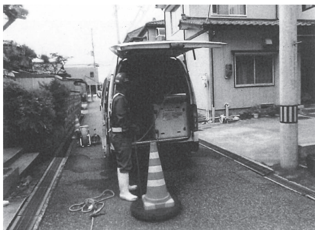
写真1 TVカメラによる調査作業状況
