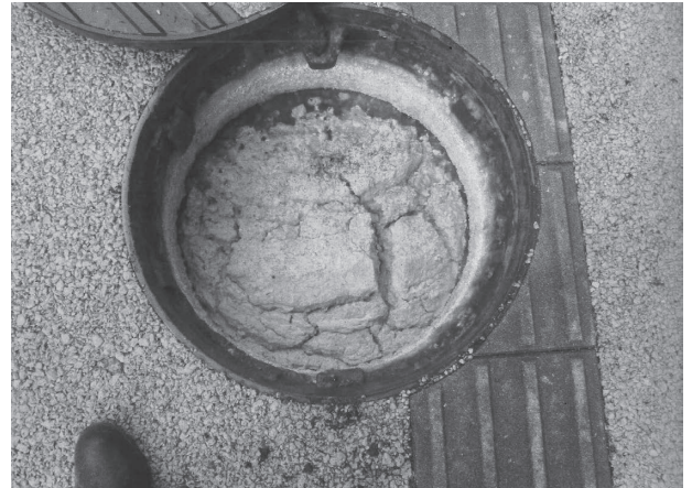
写真4 油脂により詰まった公共ます
