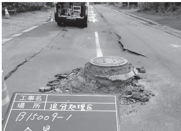
写真3 マンホールの突出 (安平町)
