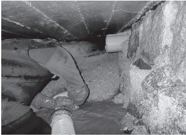
写真7 水路の浚渫工事
