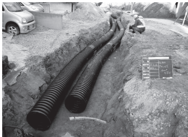
写真3 仮管布設
