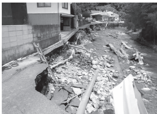
写真6 単管パイプを利用した仮復旧 ((左) 復旧前、(右) 復旧後)
