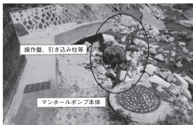
写真4 マンホールポンプの損壊
