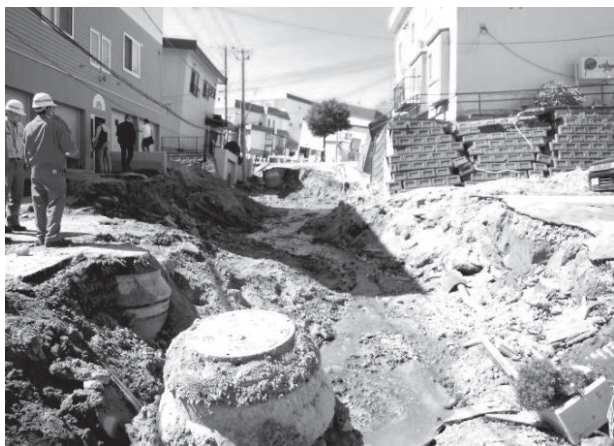
写真1 応急復旧着手前の様子
