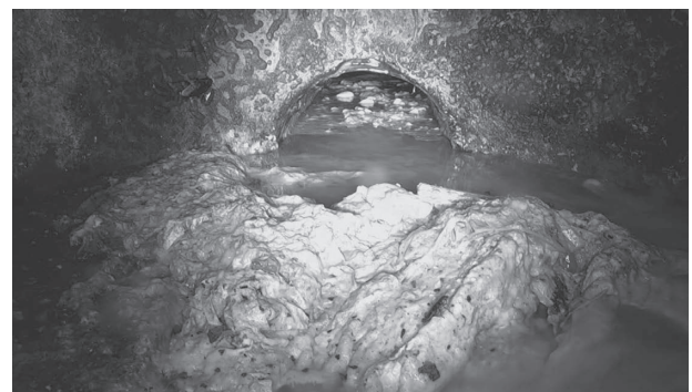
写真2 油脂付着の状況
