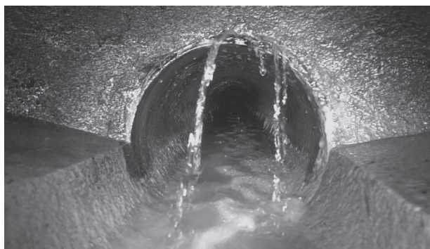
写真1 浸入水の状況
