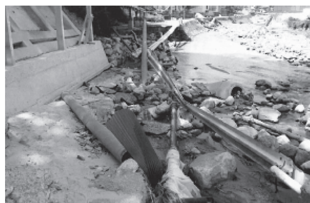
写真5 下水管の流出
