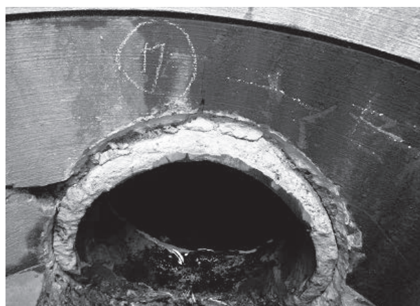
写真6 ヒューム管管口破損 (厚真町)
