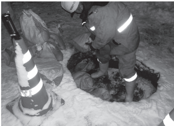
写真6 降雪時の道路陥没現場(土嚢による埋戻し作業中)
