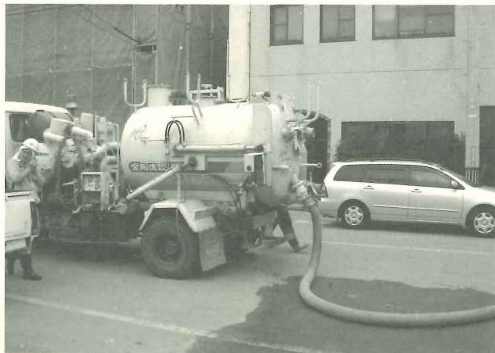
写真一 3 作業中の吸引車
