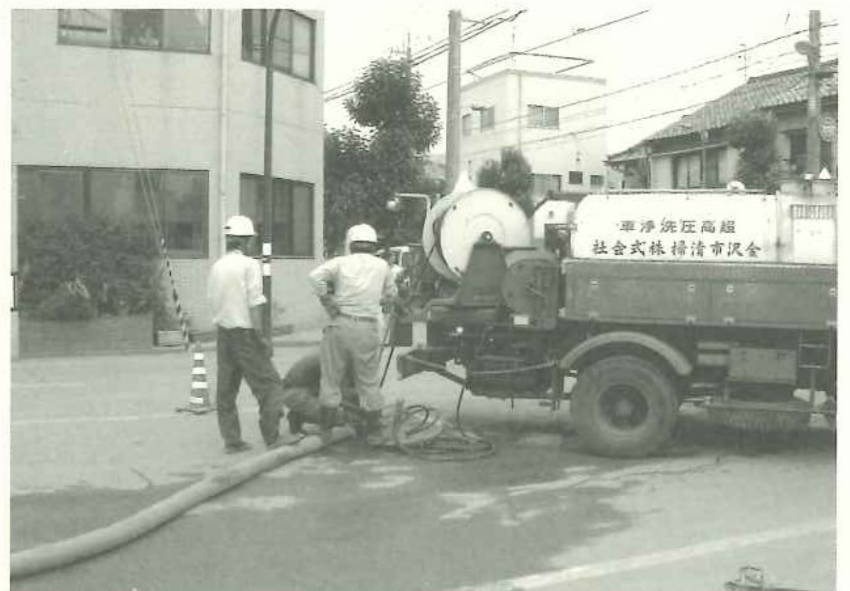
写真一 4 作業中の高圧洗浄車
