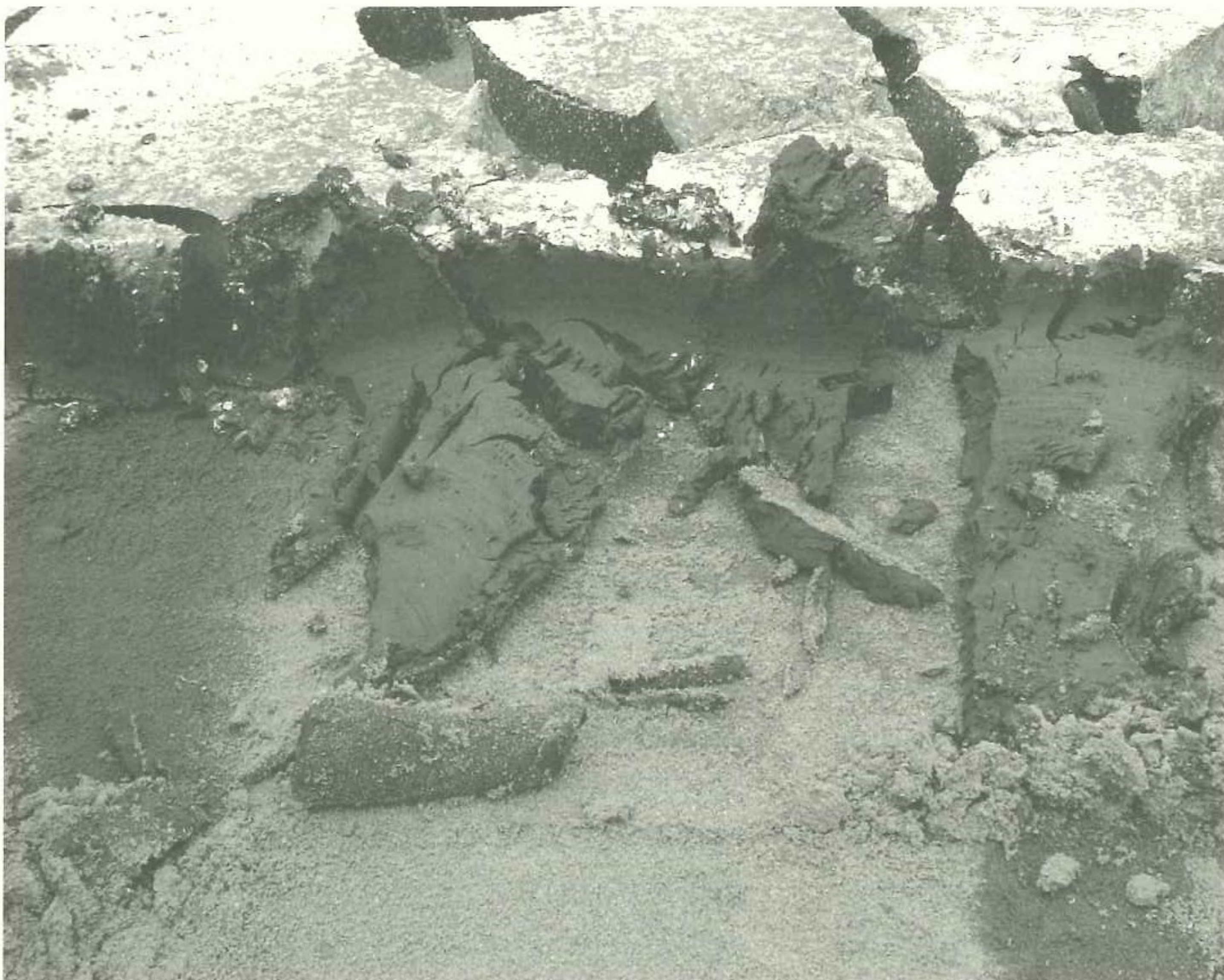
写真一 2 堆積していたシルト状土砂（土砂の上に石灰が散布されている）
