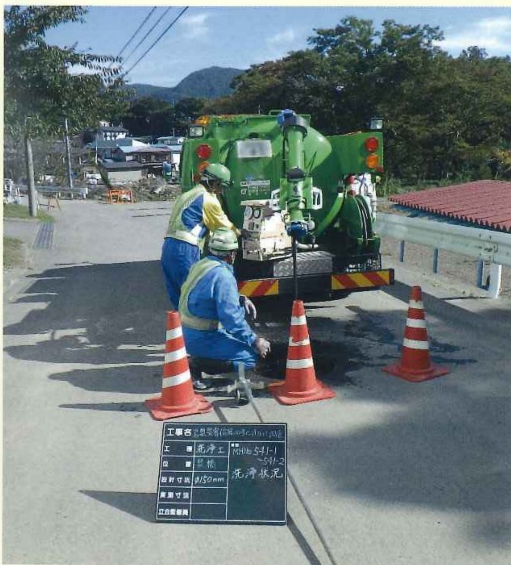
管内調査の様子
