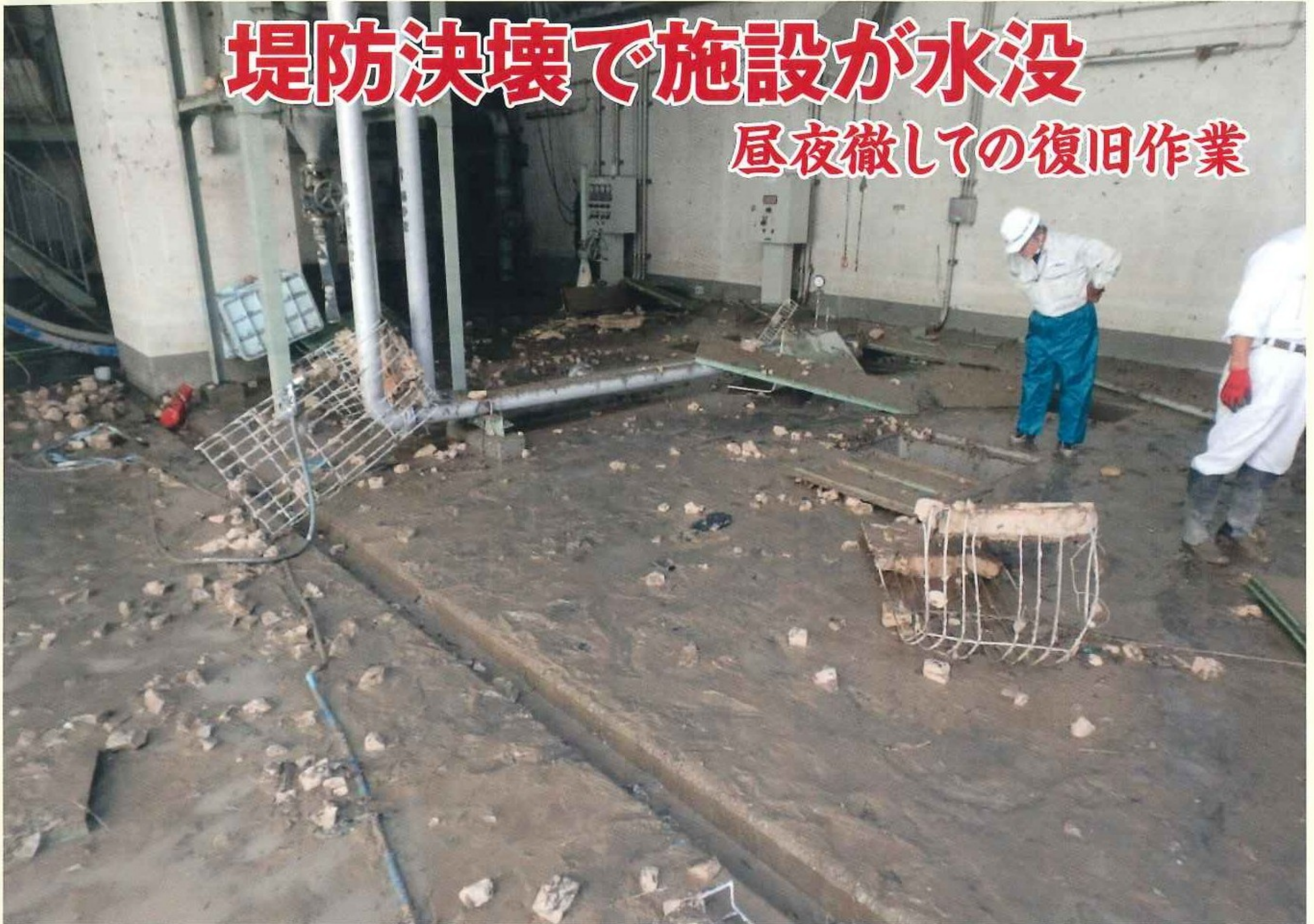
下妻中継ポンプ場は水没し、地下ピットは土砂で埋まった
