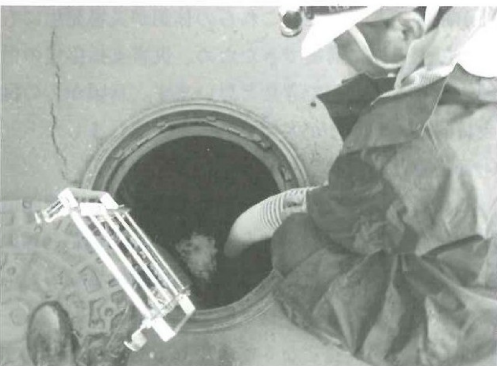
吸引作業中のマンホールの状況
