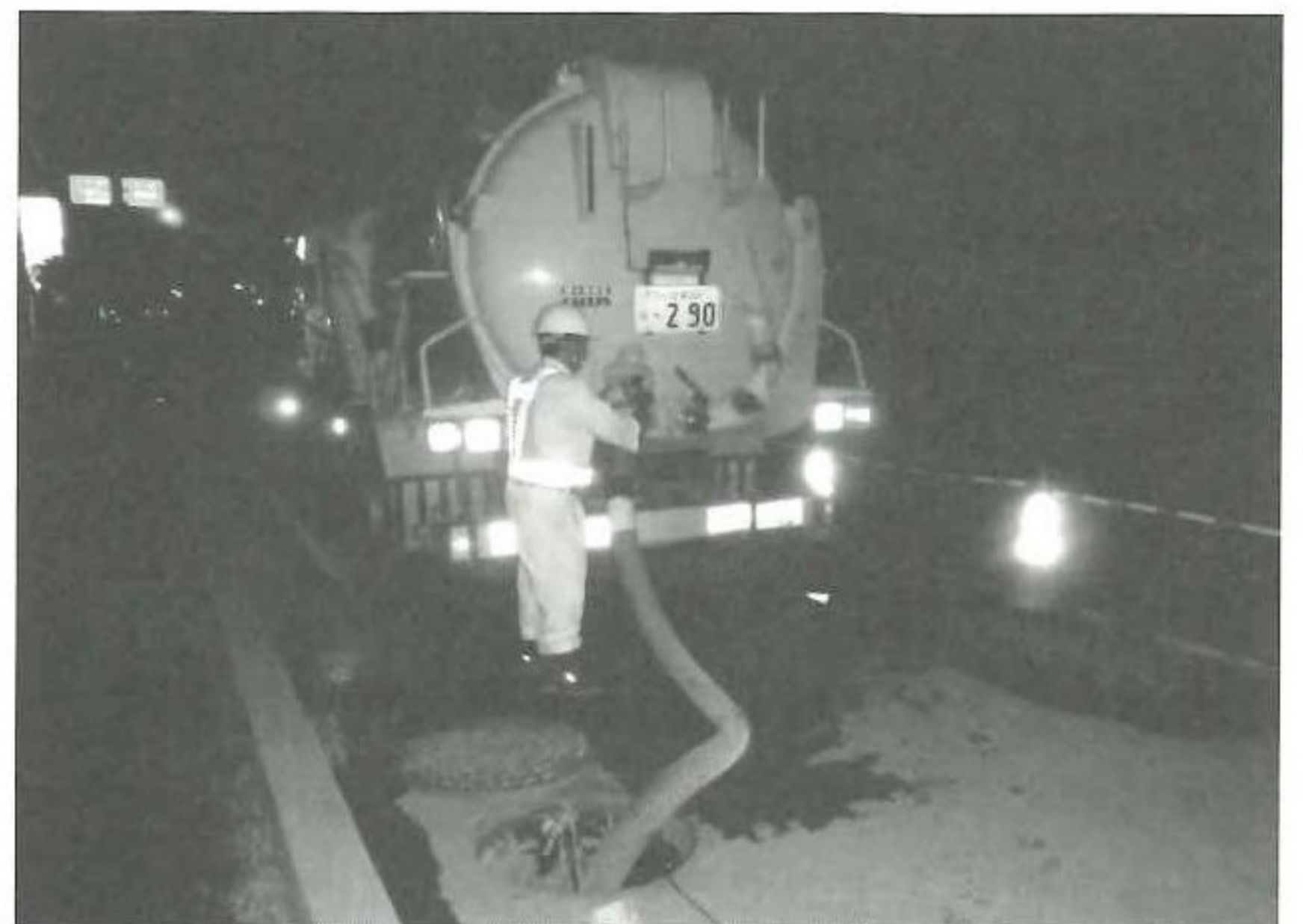
夜間作業の状況
