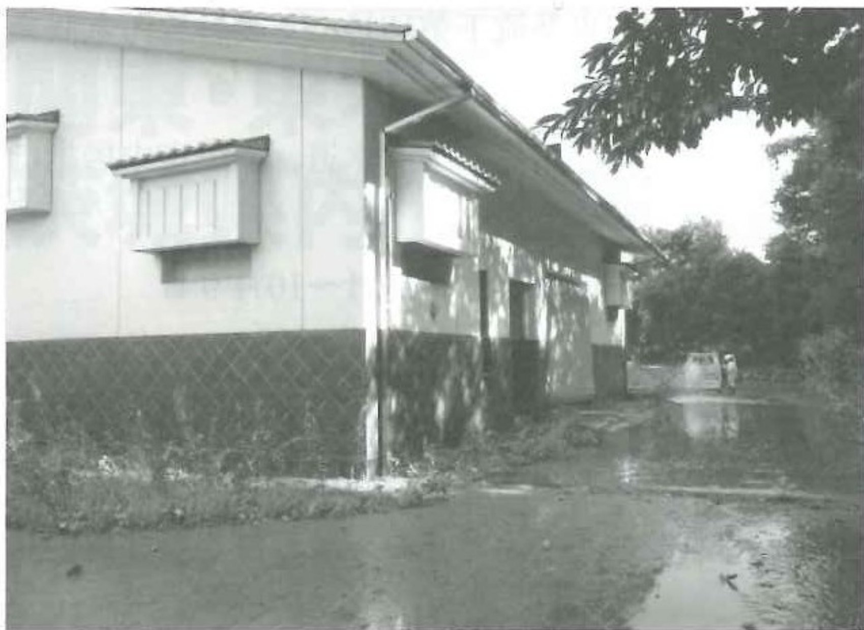
下妻中継ポンプ場（水が引いた状態）
