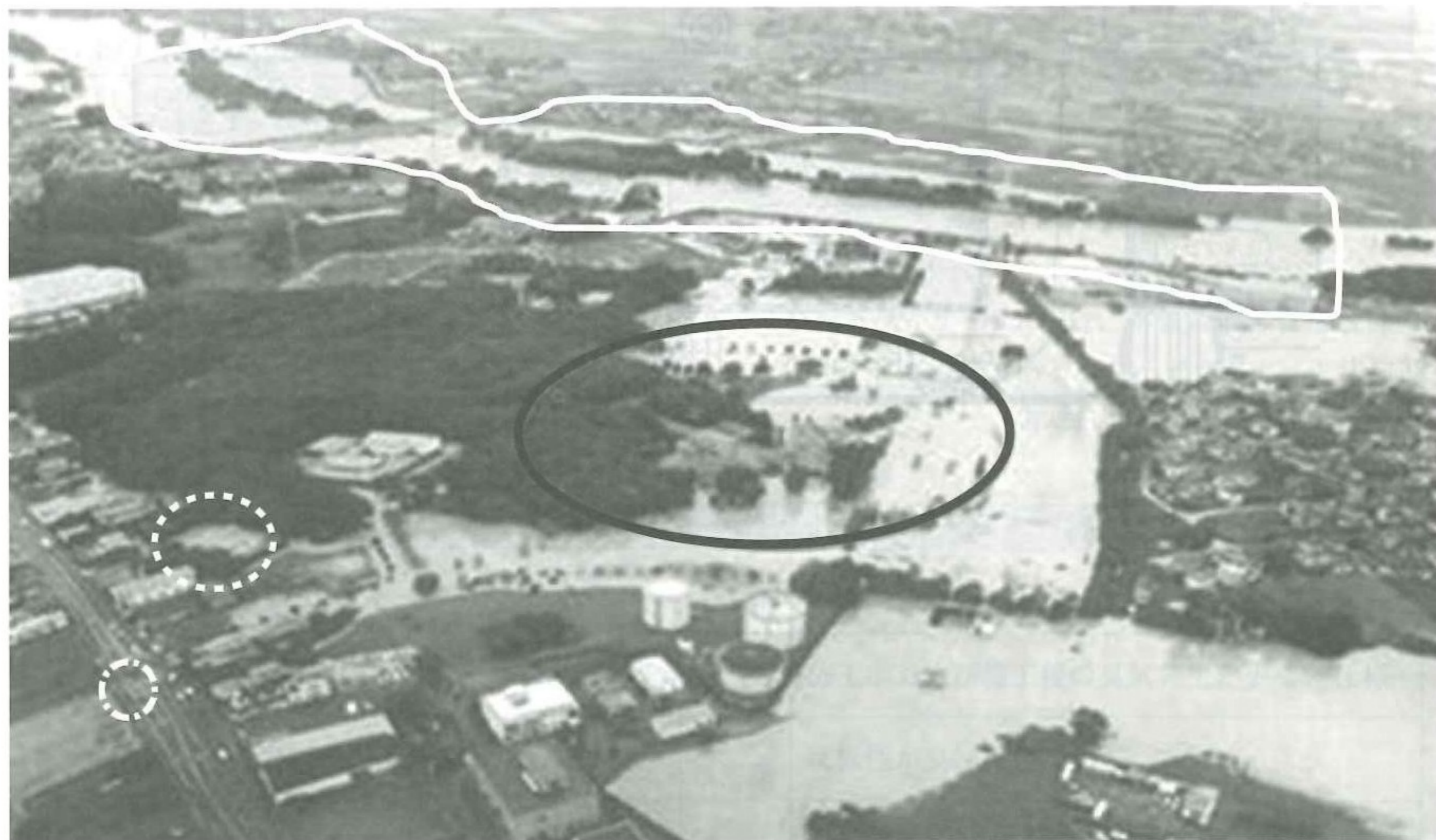
洪水全体写真(白線:鬼怒川、黒線:ピアスパーク下妻、----:水没した下妻ポンプ場、- - - -:作業箇所)
