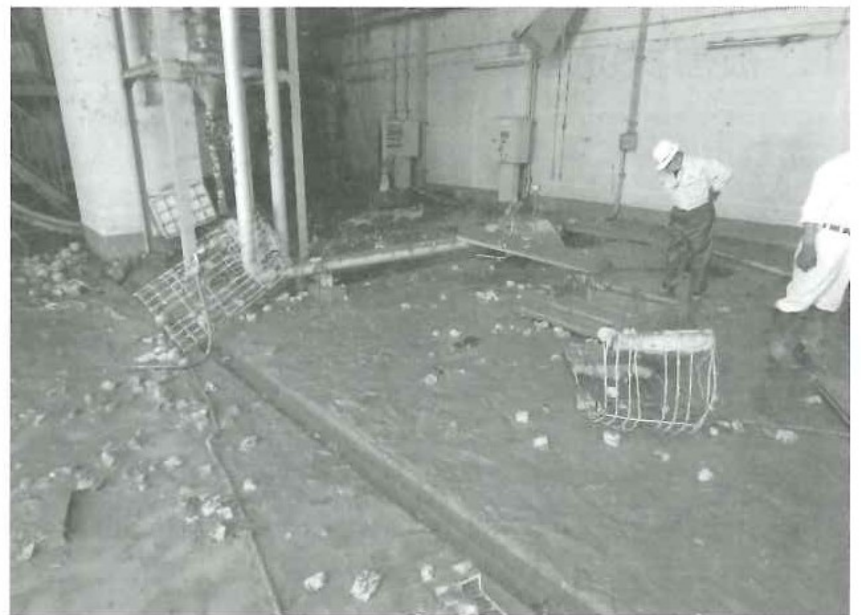
ポンプ場地下ピット（地下15m程度）
